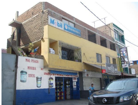
Figura 8. Vivienda de albañilería confinada representativa del Sector 02.
