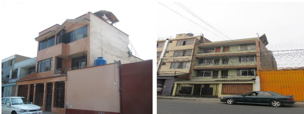
Figura 5. Edificaciones de mampostería de tres y cuatro pisos con techo aligerado.
