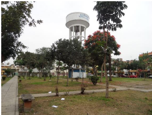
Figura 257. Reservorio elevado aporricado de concreto armado - sector 08
