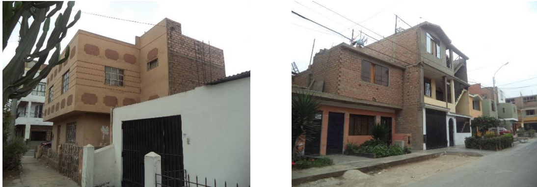
Figura 20. Edificaciones con techo de losa aligerada del Sector 06
