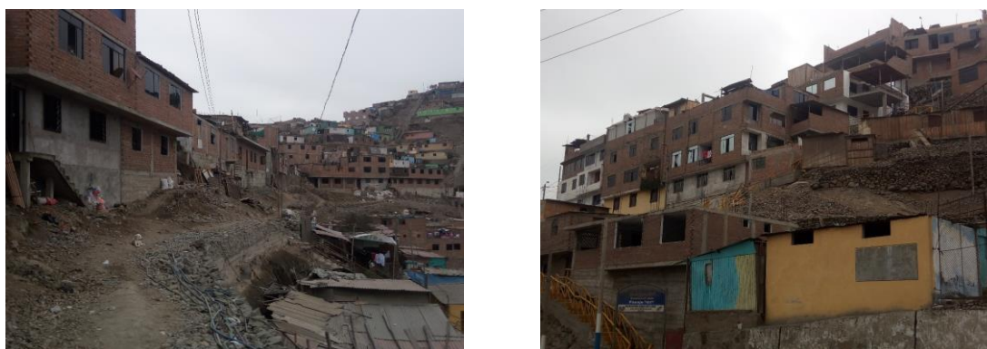
Figura 23. Edificaciones ubicadas en la parte alta del cerro sin tarrajeo, que presenta un estado de conservación regular
