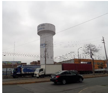
Figura 258. Reservorio elevado con placas de concreto armado - sector 08
