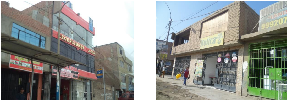
Figura 13. Edificaciones con uso comercial del sector 03
