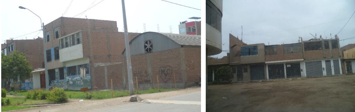
Figura 6. Edificaciones de dos pisos de techo aligerado y cobertura ligera del sector 01
