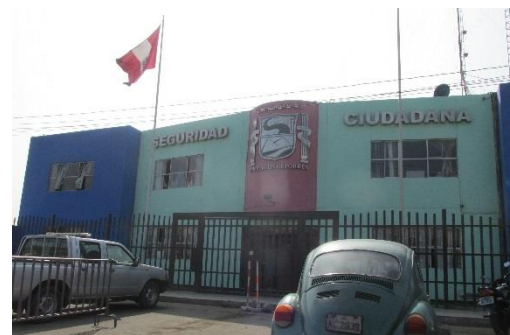
Figura 164. Municipalidad del Distrito de San Martín de Porres
