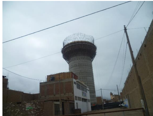
Figura 50: Tanque elevado en sector 01
