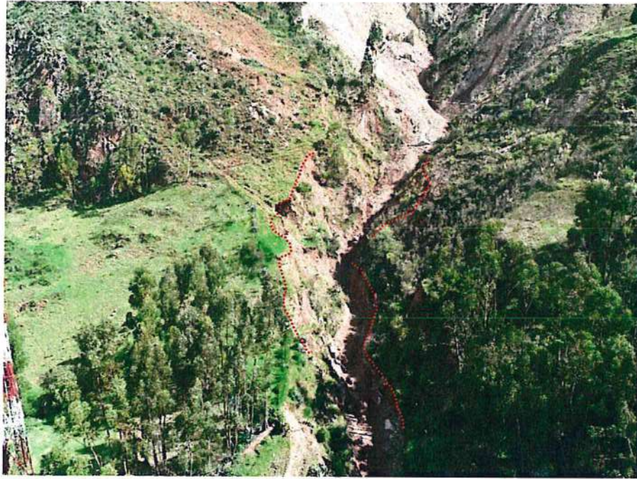
Figura 18. Presencia de derrumbes en ambas márgenes de la quebrada Puca Puca (líneas rojas discontinuas) originados por las precipitaciones pluviales intensas en esta zona
