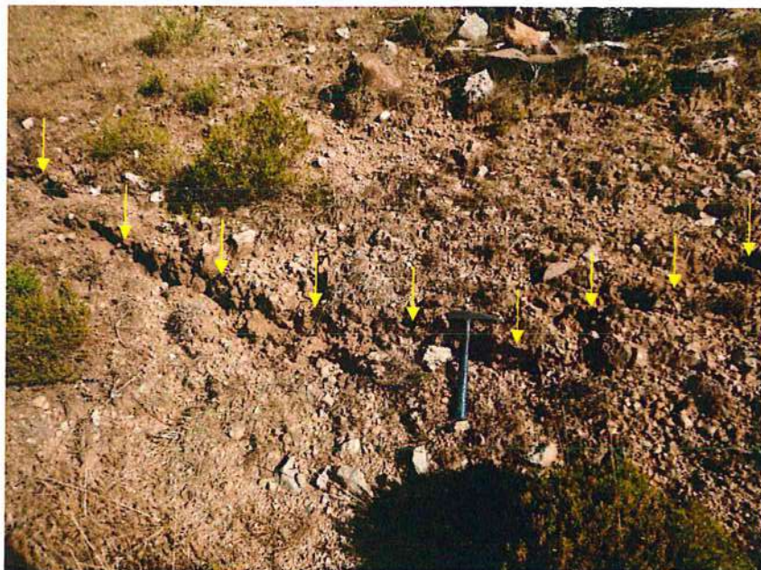
Figura 14. Agrietamientos longitudinales al escarpe principal del deslizamiento. Las grietas evidencian el terreno inestable y susceptible a seguir deslizándose. Vista al suroeste
