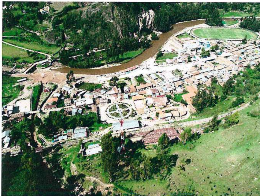
Fotografía 2. Vista al noreste de la localidad de Acoria ubicada sobre terrazas aluviales, en la margen izquierda del río Ichu
