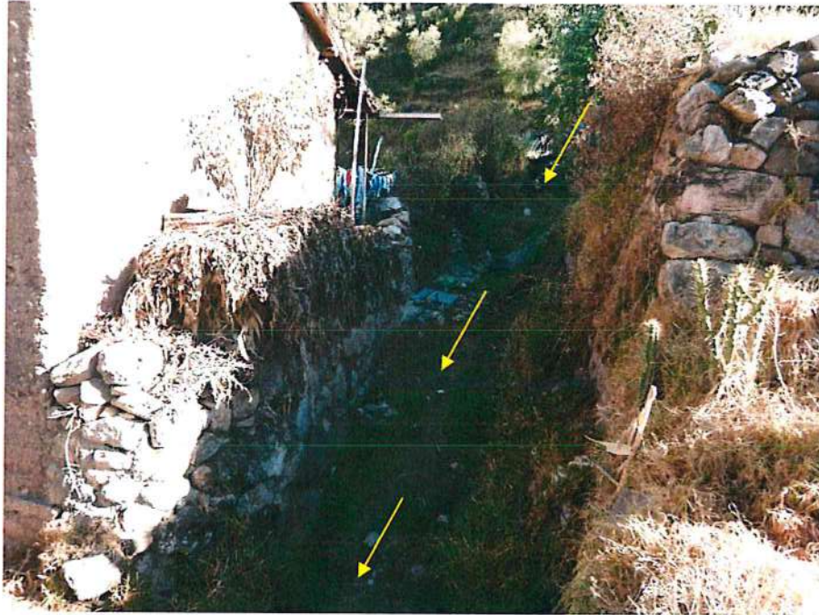
Figura 22. Cárcava canalizada a la altura del área urbana de Acoria. En épocas de lluvias las aguas de escorrentía son drenadas por debajo de las calles de la zona urbana. Vista al suroeste
