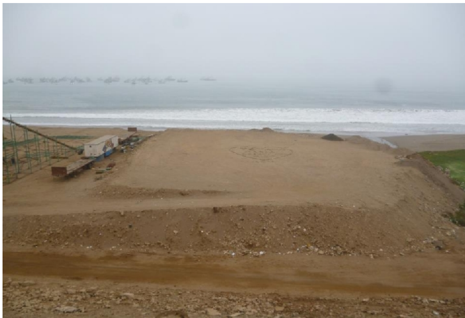
Figura 33: Terraplén de 2 metros de espesor sobre el nivel natural del terreno
