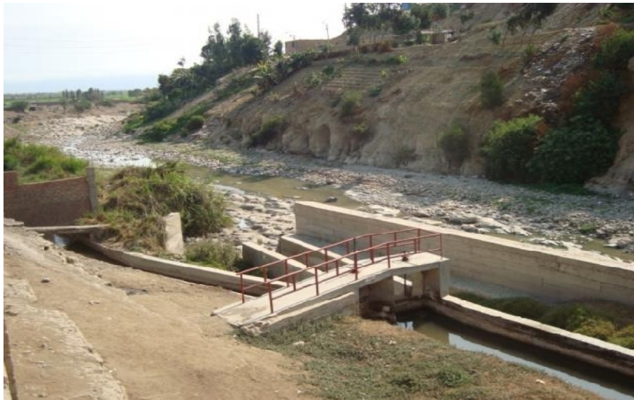
Figura 42: Río Huaura cerca del puente Huaura. Sistemas de captación de agua para la agricultura.
