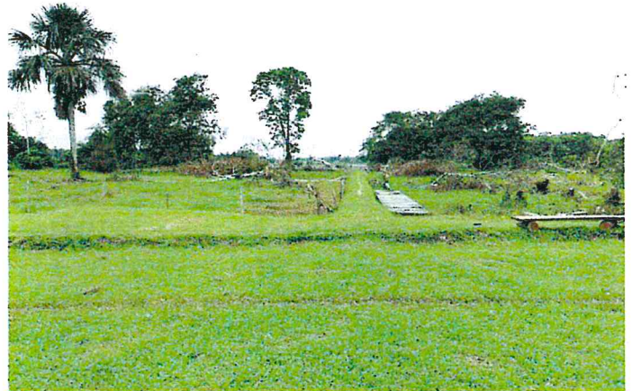
Proyecto antiguo de levantamiento de rasante con sacos rellenos con tierra a modo de defensa ribereña que rodea el ámbito de la comunidad
