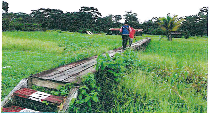
Puente presente en la localidad de Puerto Lupita
