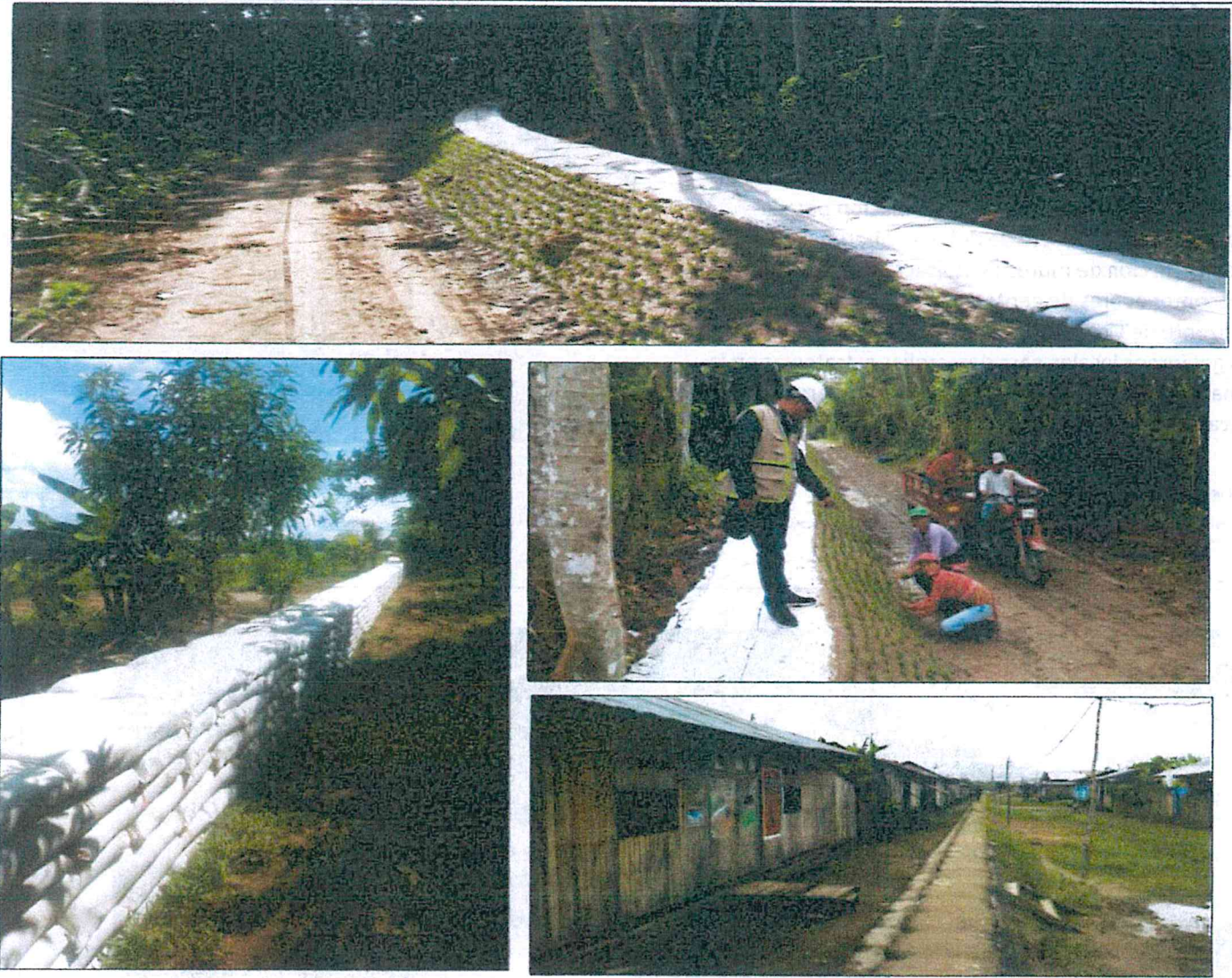
Vistas de la estructura final de la Defensa ribereña a modo de muro de contención frente a inundaciones
