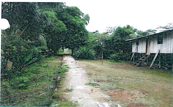
Proyecto antiguo de levantamiento de rasante con sacos rellenos de tierra a modo de defensa ribereña que rodea el ámbito de la comunidad
