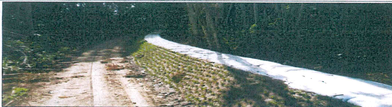
Vistas de la estructura final de la Defensa ribereña a modo de muro de contención frente a inundaciones
