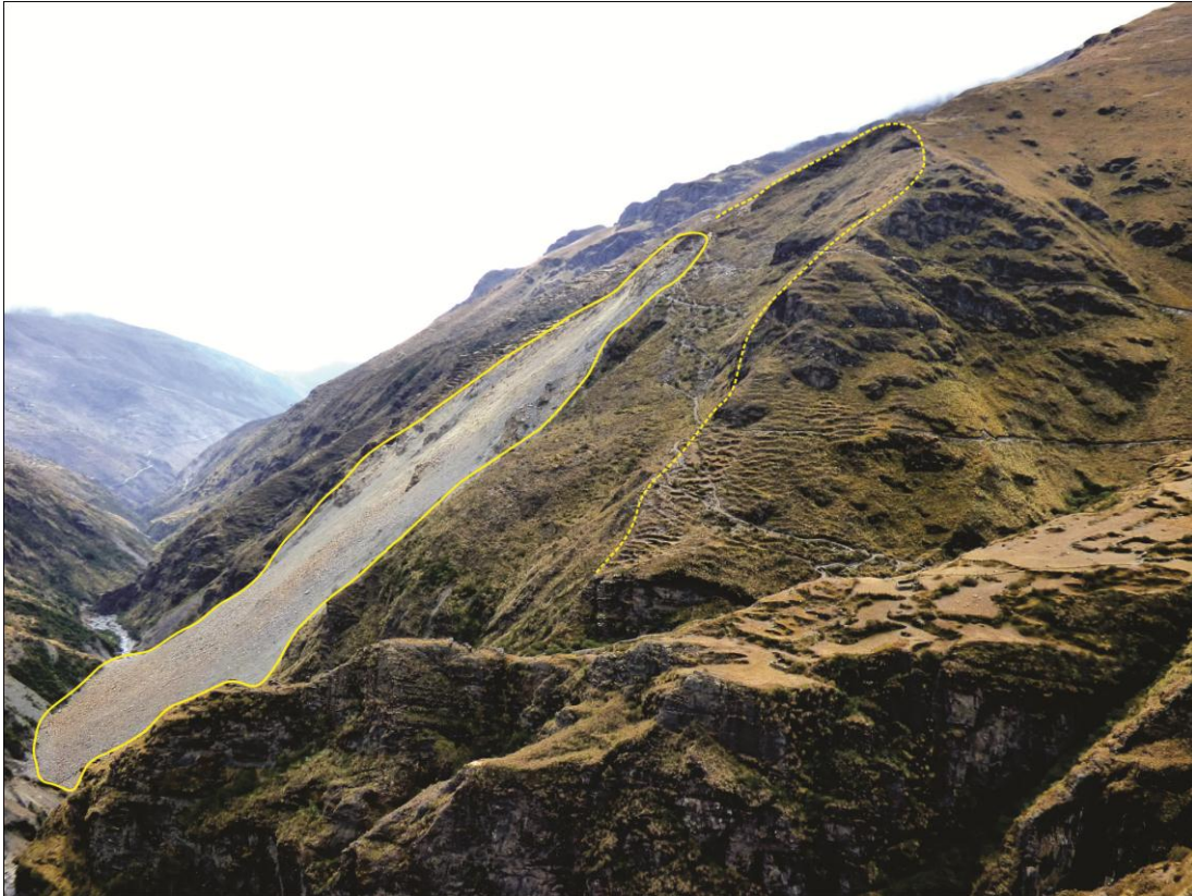
Foto 12. Con líneas continuas se delimitó el derrumbe que ocurrió el 14 de marzo del presente año y con líneas discontinuas la escarpa de derrumbe antiguo.
