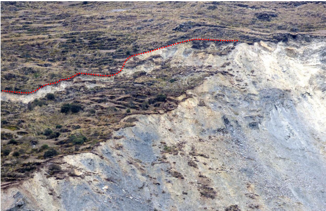
Foto 18. Escarpe del deslizamiento – derrumbe y agrietamientos en la cabecera del derrumbe.
