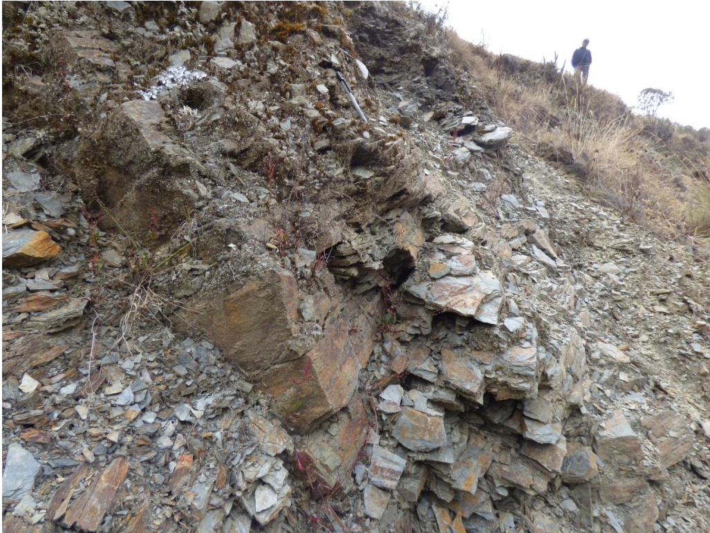
Foto 3. Afloramiento rocoso fracturado de la Formación Ananea ubicada en la margen izquierda del río Jarahuaña.
