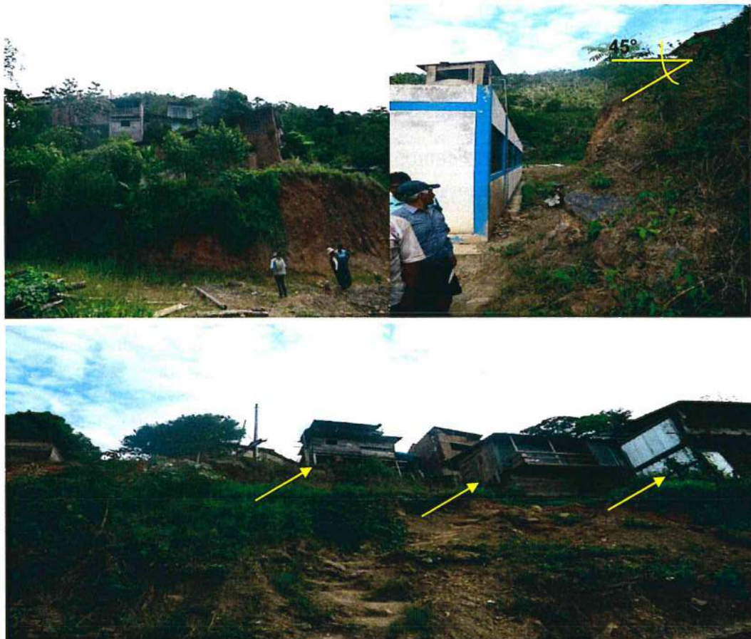
Figura 12. La pendiente del terreno es un factor condicionante importante en la inestabilidad de las laderas de las montañas, sobre las cuales se ubican las viviendas del caserío de Arco Punco.
