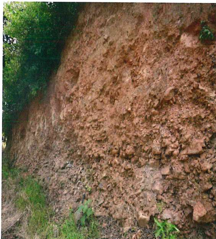
Fotografía 2. Depósito coluvio-deluvial producto de deslizamientos antiguos. Vista al noroeste
