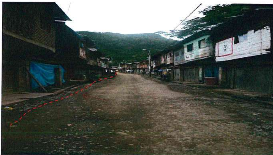
Figura 18. Viviendas afectadas y otras que podrían serlo debido al asentamiento del terreno (línea discontinua de color rojo)
