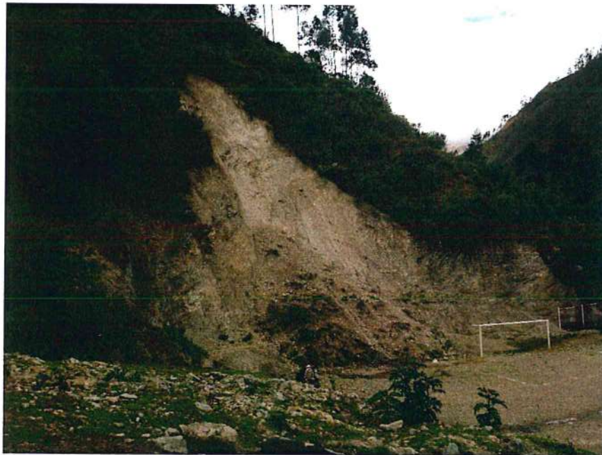
Fotografía 7. Derrumbes en la parte baja de la quebrada Ispingol (margen izquierda) que afectan al campo deportivo del anexo de Colpa. Vista al sur
