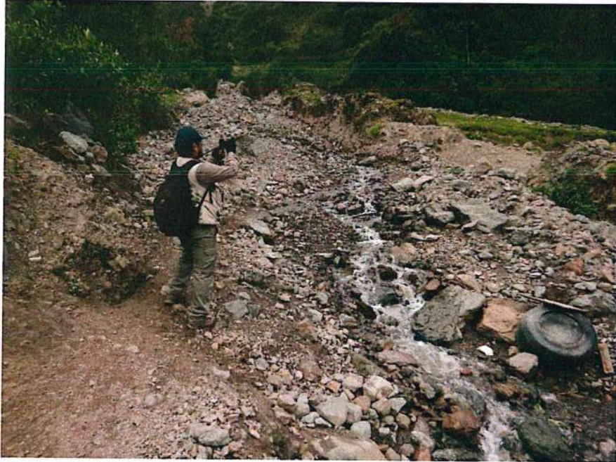
Fotografía 15. Los flujos de detritos han rellenado el cauce natural de la quebrada Ispingol, por lo cual se debe realizar la limpieza y profundización del cauce. Vista al noreste
