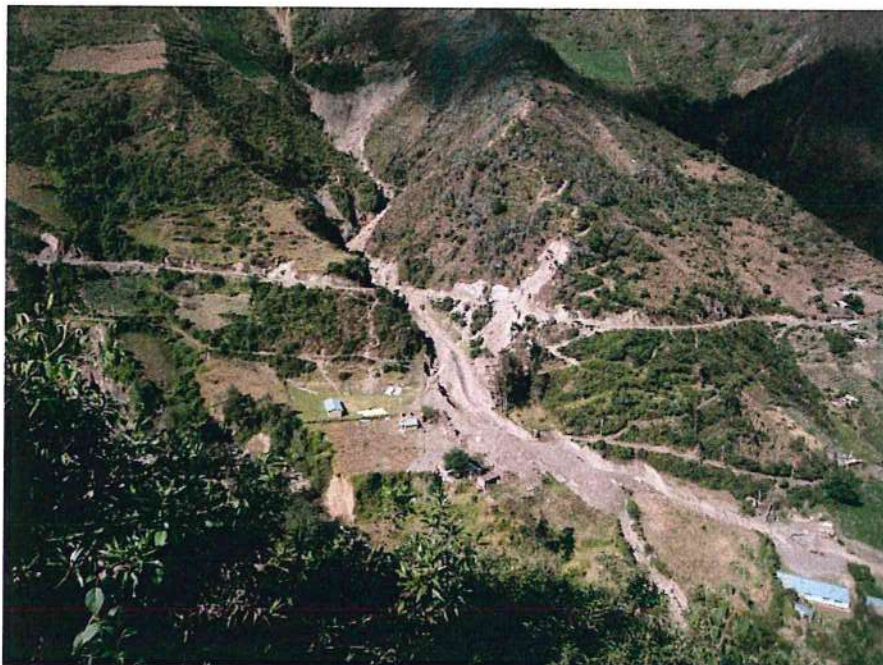
Fotografía 10. Flujos de detritos que afectaron viviendas de la Hacienda Colpa (2011), cabe mencionar que las viviendas se encuentran muy cerca de la quebrada. Tomado de Vílchez & Ochoa (2014)
