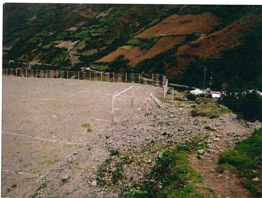
Fotografía 14. Campo deportivo del anexo de Colpa afectado por los flujos de detritos ocurridos el presente año. Vista al suroeste
