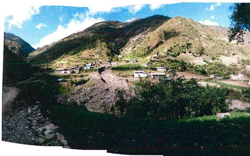
Fotografía 11. Flujos de detritos en el anexo de Colpa (2011), las viviendas se encuentran muy cerca de la quebrada Ispingol
