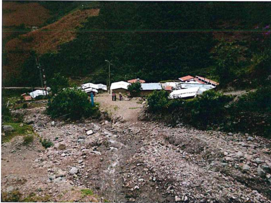
Fotografía 2. Vista al suroeste del anexo de Colpa ubicado sobre piedemontes aluvio-torrenciales, en ambas márgenes de la quebrada Ispingol
