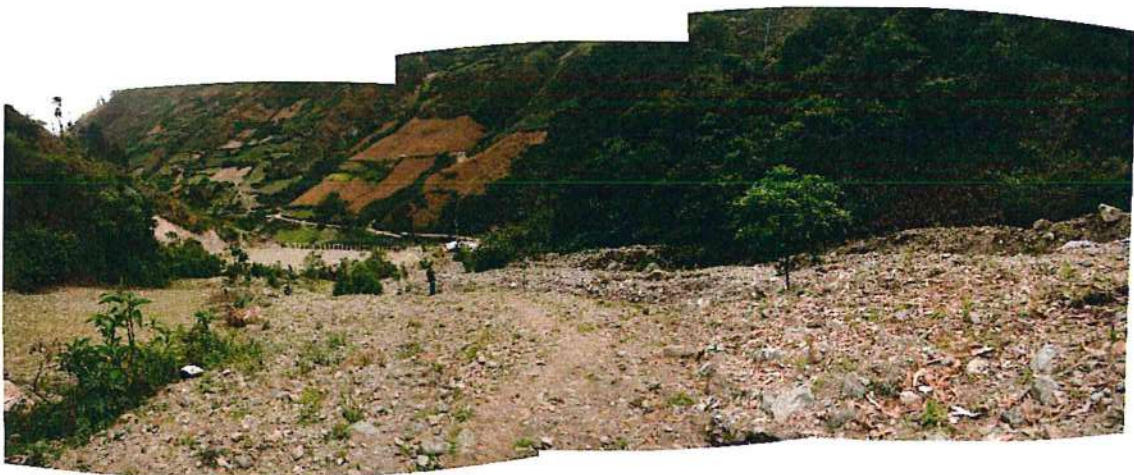
Fotografía 12. Vista panorámica al suroeste de los flujos de detritos en la parte alta del anexo de Colpa, se observa el desborde de los flujos hacia la margen izquierda de la quebrada Ispingol
