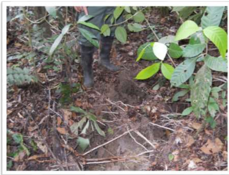
Foto N° 7: Zona media del deslizamiento, grietas con una apertura promedio de 0.70 m, en suelos blandos, formados principalmente por arenas sueltas.
