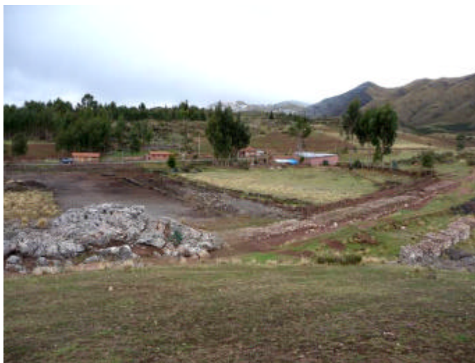
Foto 12. Vista panorámica de la comunidad de Wayllarqocha, el humedal o Oocha 1 y el muro o dique de contención 1.
