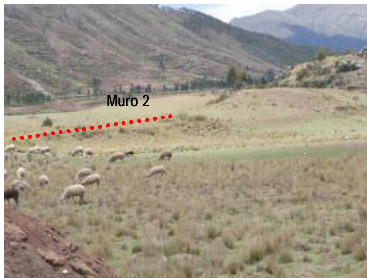
Foto 24. Dique de tierra, Muro 2 (en rojo) al norte de la Qocha 2A.
