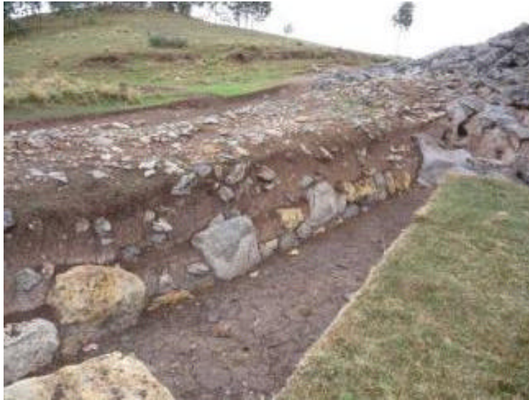
Foto 13. Grandes bloques labrados de roca caliza en la parte baja del muro de represamiento.
