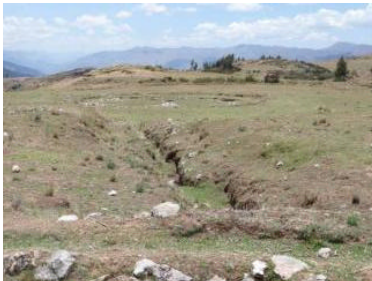
Foto 32. Canal de conducción orientada hacia el este, al fondo la qocha 3.
