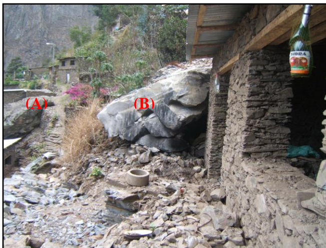
Foto 5.- Se muestra la dimensión de los bloques (A y B) del último evento de caídas de rocas, los cuales afectaron a viviendas.
