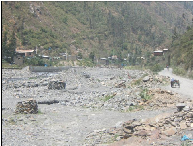
Foto 8.- Zonas de inundación fluvial, ubicada aguas arriba del puente Sandía. En ambas márgenes falta culminar las defensas ribereñas.
