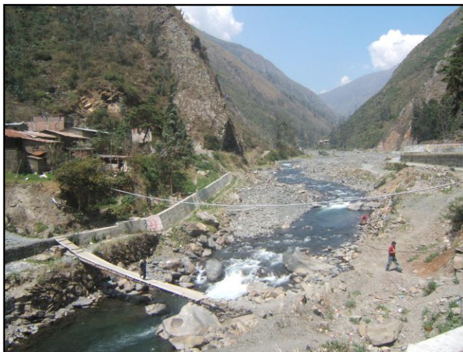
Foto 3.- Sector aguas arriba del puente Sandia, se muestran las terrazas bajas.
