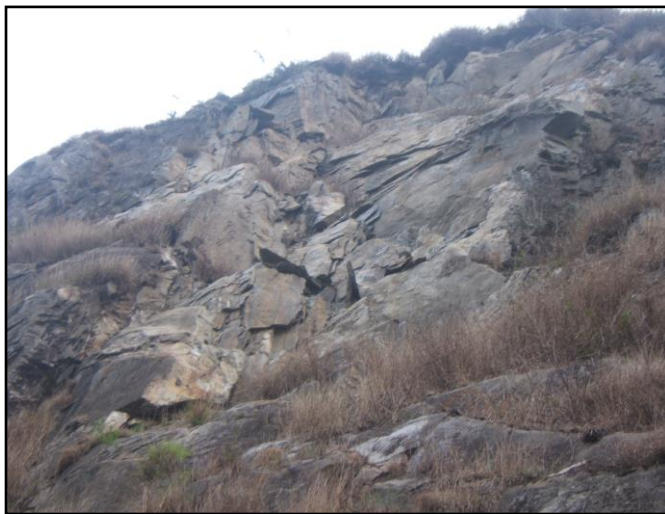
Foto 2.- Vista detallada del Farallón donde se muestra los bloques suspendidos, que pueden ceder por efectos de la gravedad, lluvias o sismo.
