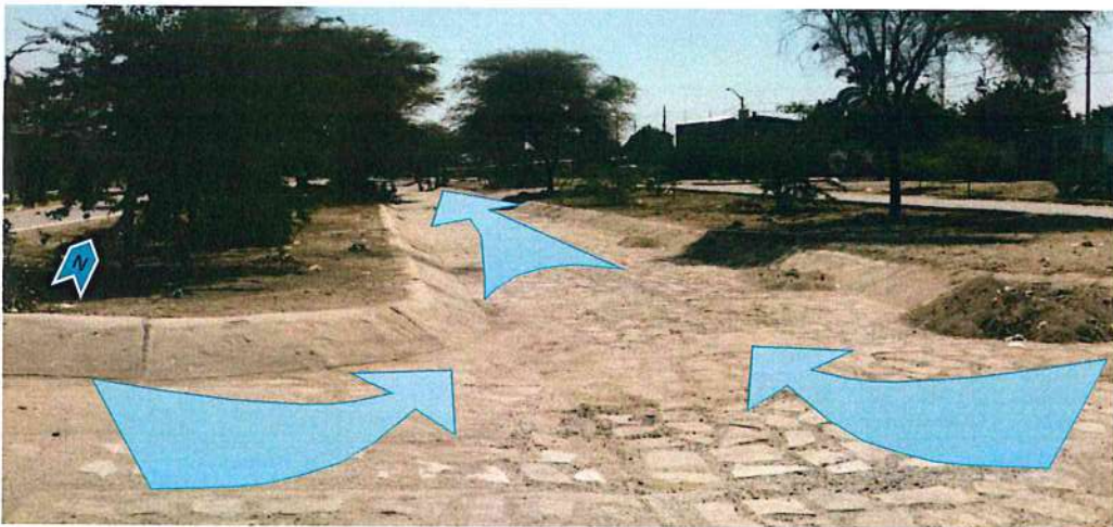
Figura 13. Canal vía San Felipe que drena el agua de escorrentía de norte a sur hasta llegar a la Av. Circunvalación 9 de Octubre.
