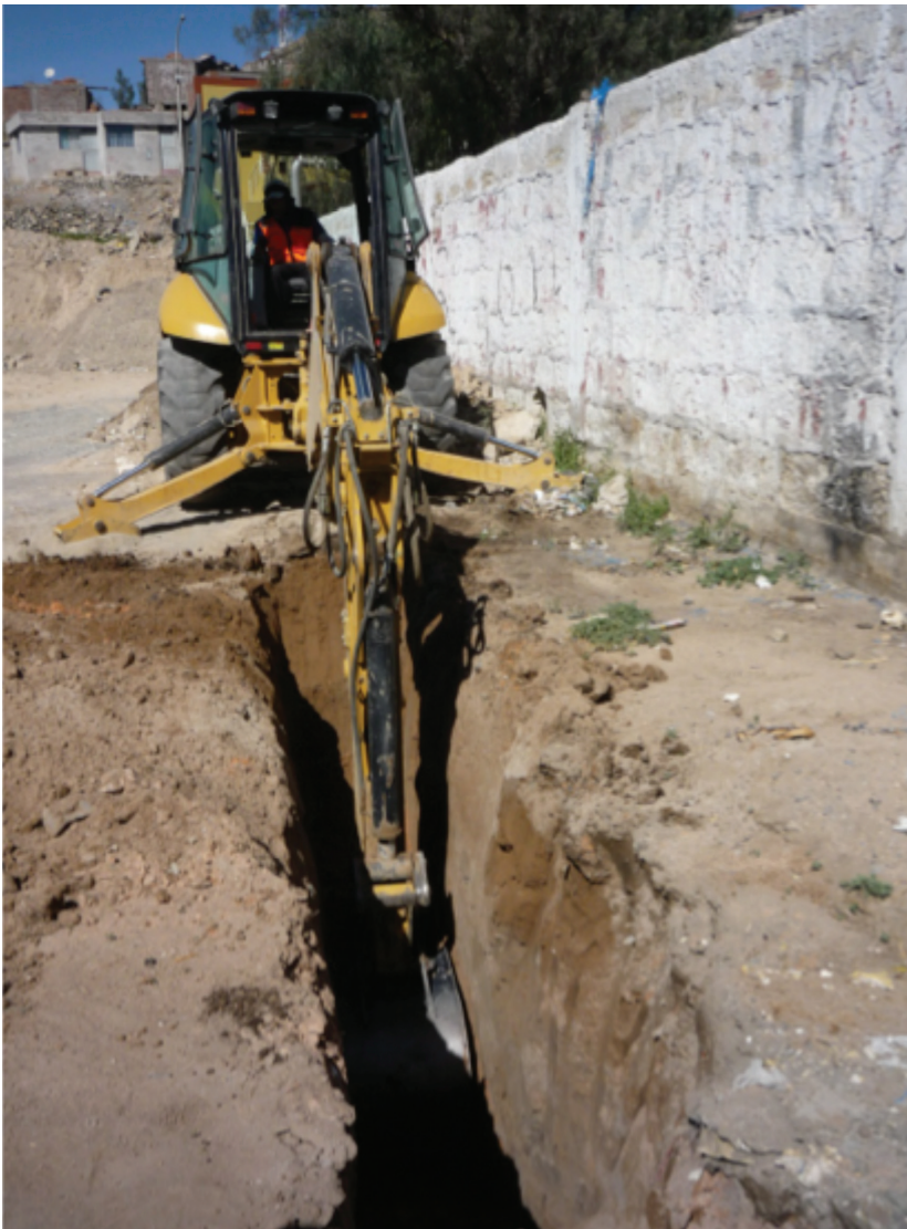
FIGURA 5. Calicata construida por una retroexcavadora proporcionada por el Municipio del Distrito de Sachaca.
