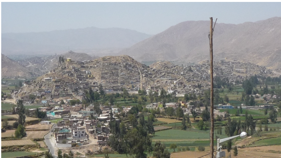
FIGURA 26 Viviendas asentadas sobre la ladera del cerro donde se ubican las Asoc. 28 de Julio y José Maria Arguedas. Obsérvese que el cerro está cubierto por viviendas y de ocurrir un movimiento en masa, estas serían afectadas
