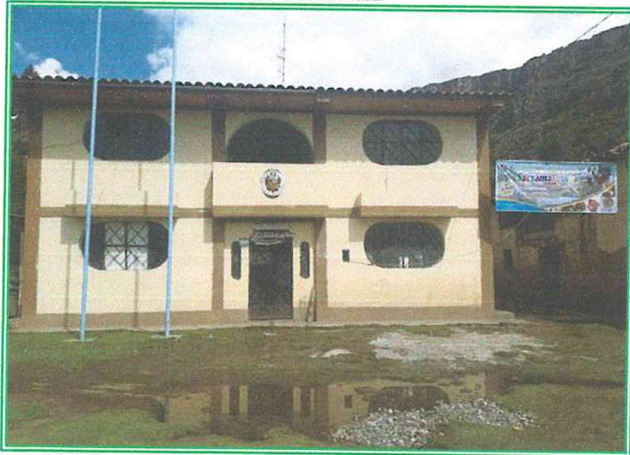
Se observa infraestructura de la municipalidad de Colcabamba en riesgo por la afectación del río Colcabamba y hueltas de la inundación.
