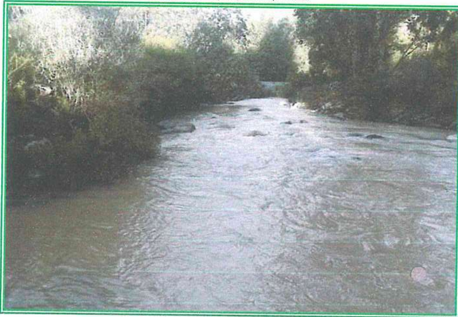
Los pobladores protegieron sus viviendas con piedras y árboles para así cuidar la vida de sus hijos, como se ve en la imagen el río alcanza al cerro con gran cantidad de material aluvial, poniendo en riesgo también a las viviendas aledañas.
