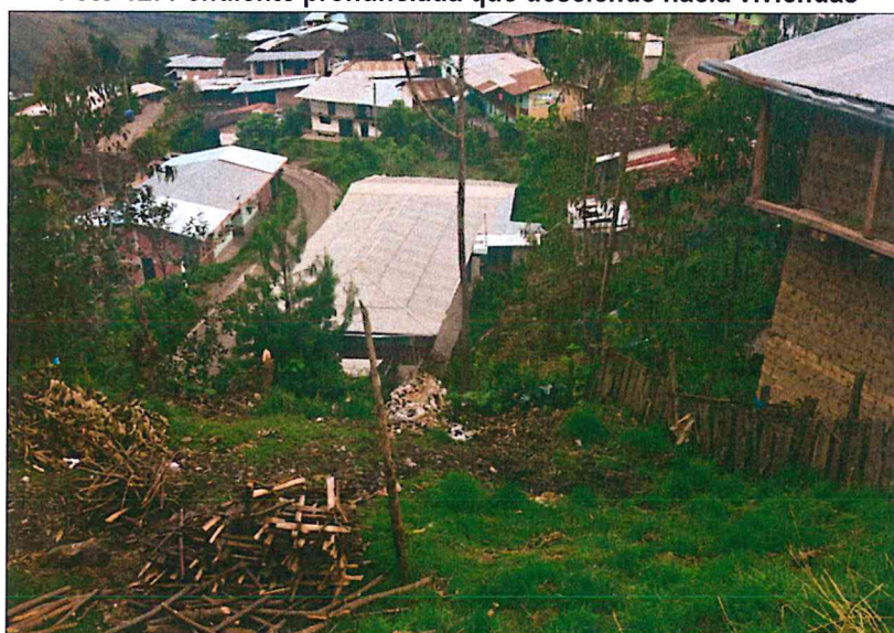
Foto 12: Pendiente pronunciada que desciende hacia viviendas
