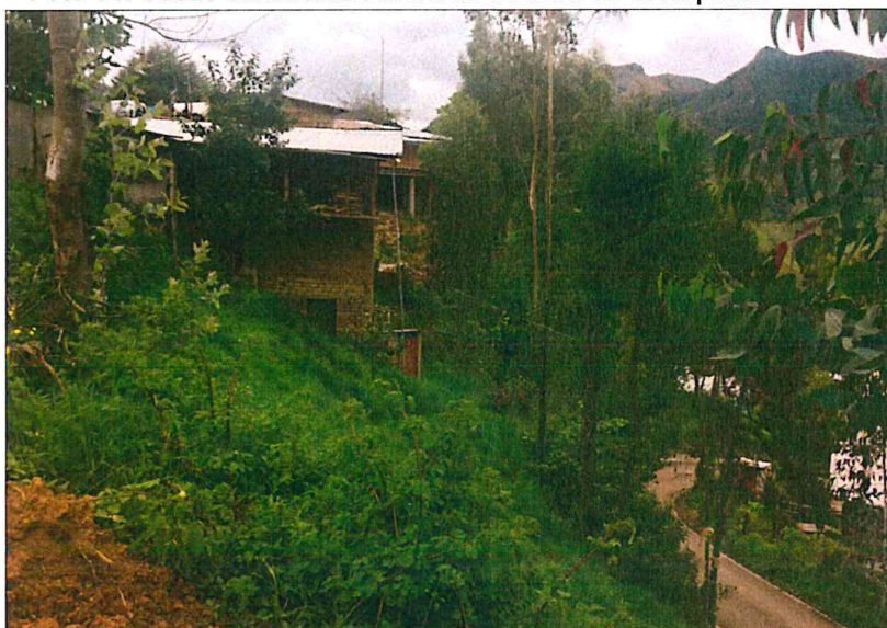
Foto 14: Casas cimentadas al borde de laderas escarpadas
