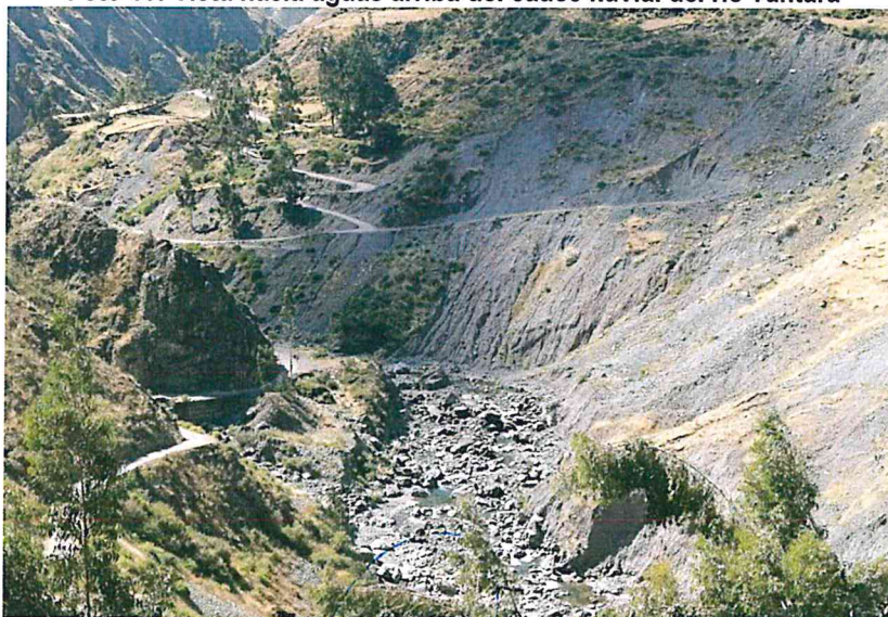
Foto 10: Vista hacia aguas arriba del cauce fluvial del río Tantara
