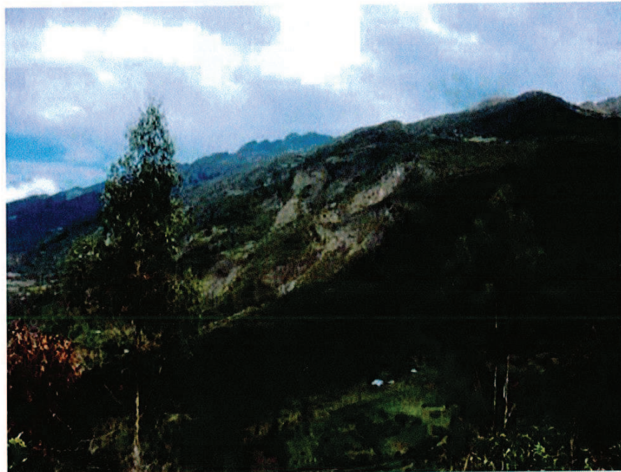
Foto 20. Vista actual del sector afectado por el deslizamiento de Cchocha y Pumararra.
