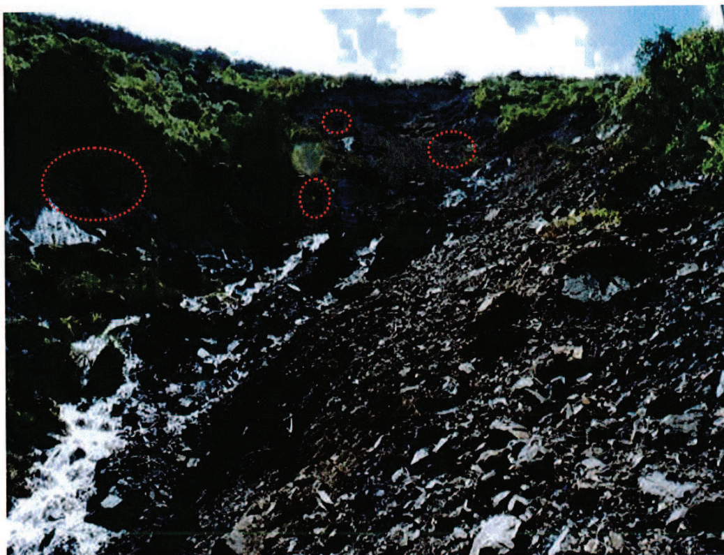
Foto 4. Los círculos de líneas entrecortadas muestra los afloramientos de agua (filtraciones) en la zona de la avalancha. Apreciándose un caudal considerable en el momento de la evaluación.
