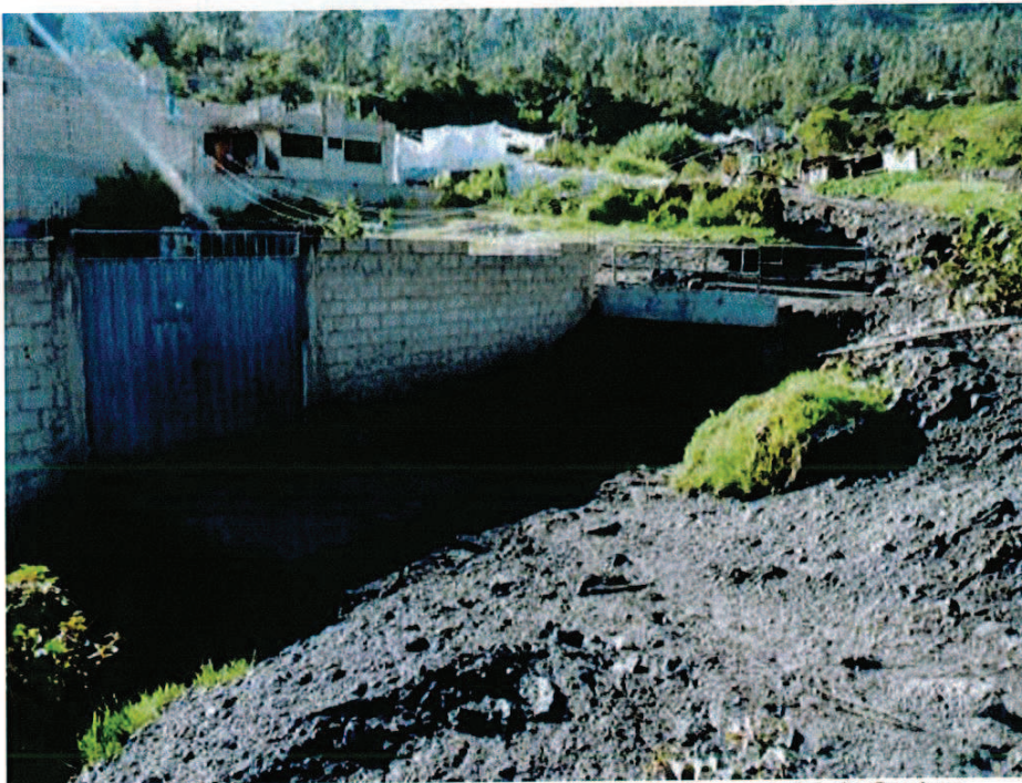
Foto 14: Puentes y viviendas que estrechan el cause del río Sayhua.
