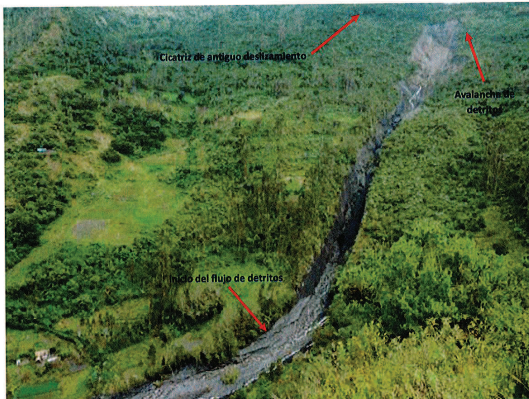
Foto 5. Zona de arranque (avalancha de detritos) del cerro Chuyllurpata y posterior desplazamiento del flujo de detritos (huayco).
