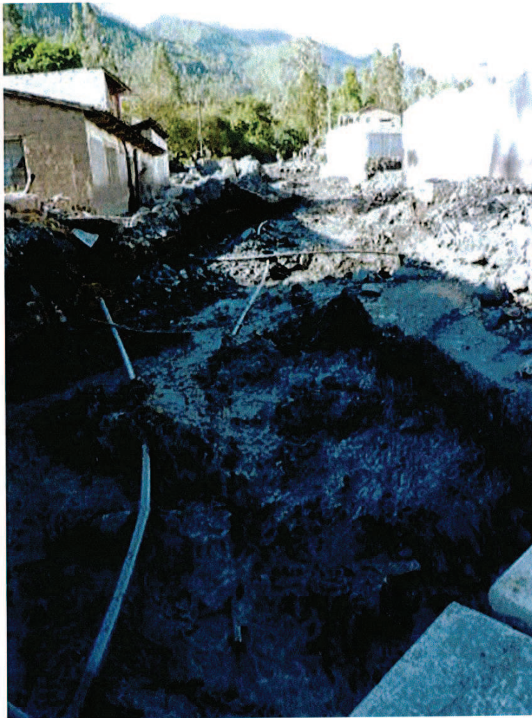
Foto 12: Erosion producida por la inundacion de detritos, se parecia como el agua erosionó pero las tuberias de agua potable y desague siguen intacta, lo que indica la casi nula turbulencia del flujo a partir de este punto.
