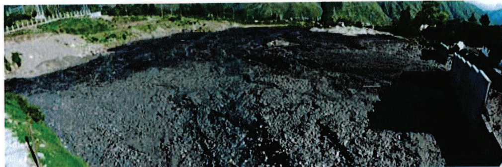
Foto 10: Vista panorámica de lo que fue el estadio de Maucacalle. Gracias a la depresión en la cual se encontraba el escenario deportivo, se pudo almacenar el 80% del material del flujo de detritos, evitando que este destruya viviendas aguas abajo.
