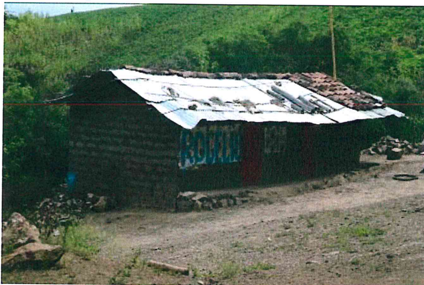
FOTOGRAFÍA N° 33: Vista de campo 13. Fuente: Propia
