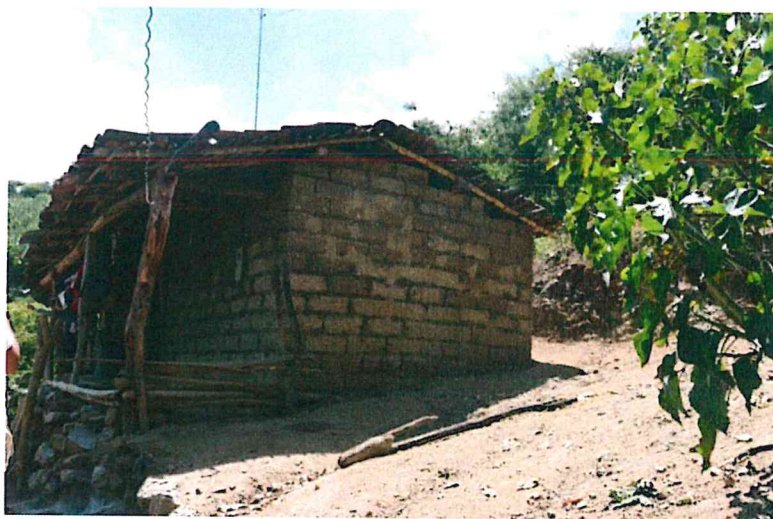
FOTOGRAFÍA N° 35: Vista de campo 9. Fuente: Propia
