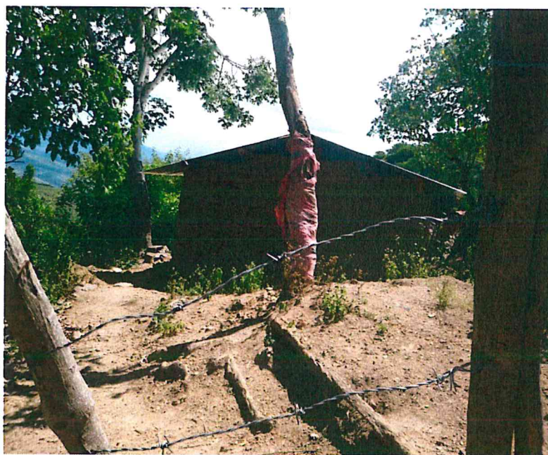
FOTOGRAFÍA N° 19: Edificaciones expuestas y susceptibles a un peligro de origen natural en el sector 11
