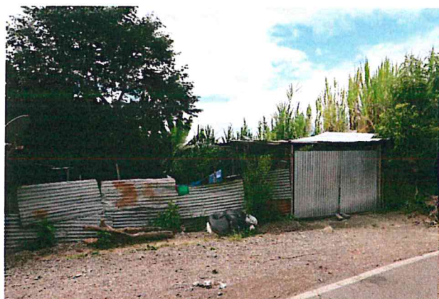
FOTOGRAFÍA N°02: Viviendas en estado precario
