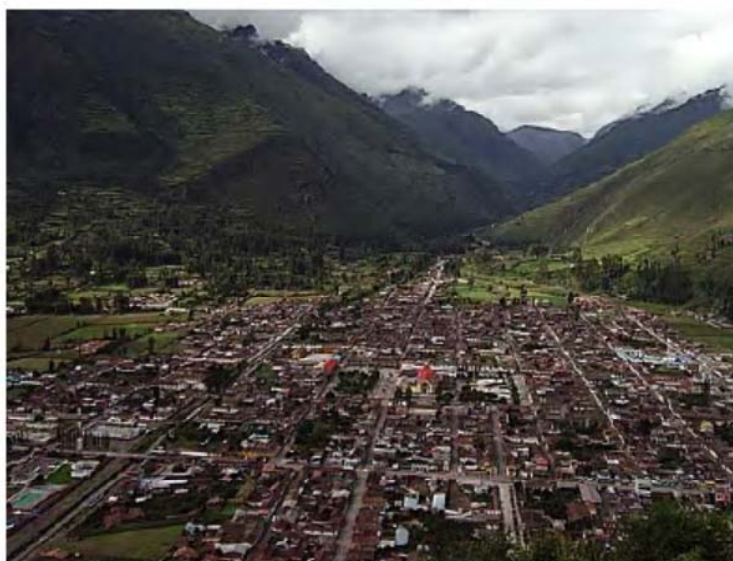
Figura 14: Vista de la quebrada Ccochoc y la ciudad de Calca.
