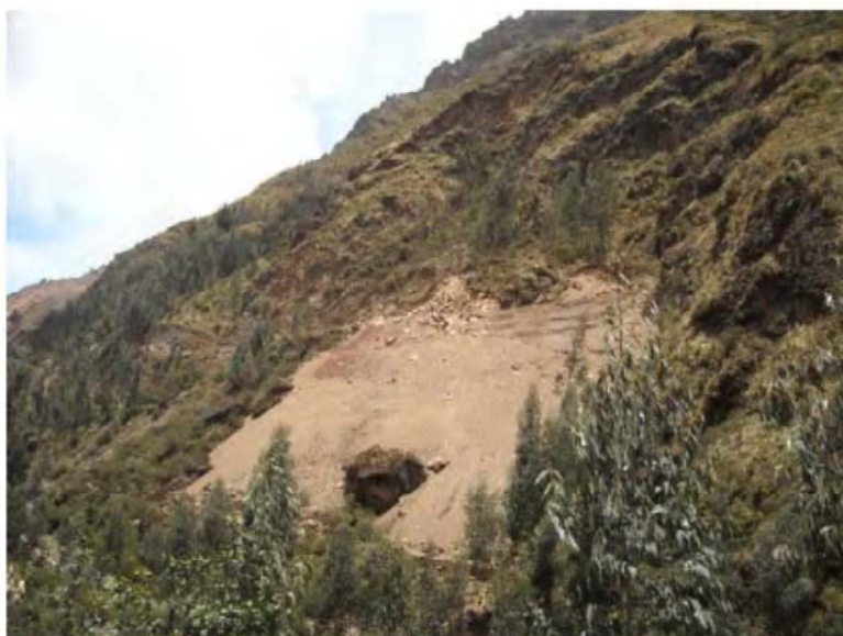
Figura 8: Material excedente del corte de talud arrojado hacia el río Ccochoc, quebrada Totorá
