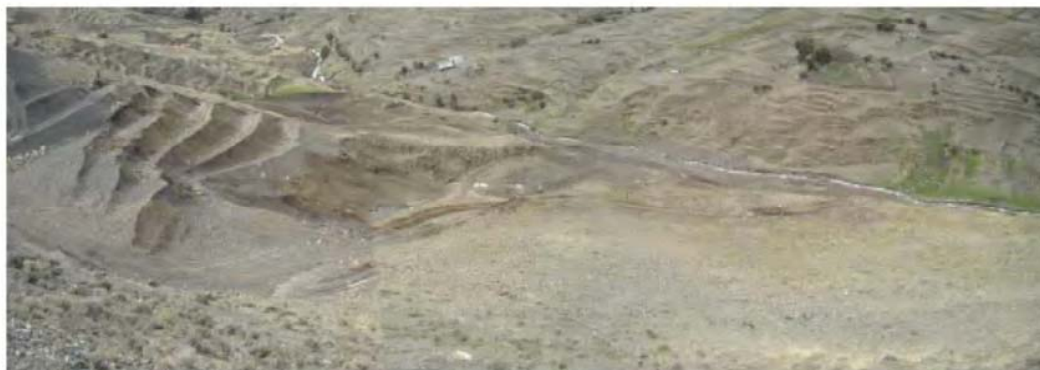
Figura 6: Base del botadero de la carretera Calca-Lares (Km 21), este genera flujos de lodo, ya que el material no tiene obras de contención y un tratamiento.
