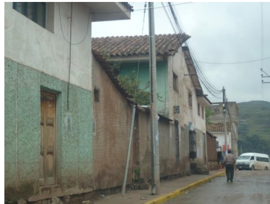
Figura 40. Edificaciones de adobe de dos niveles con uso destinado a vivienda y comercio.
