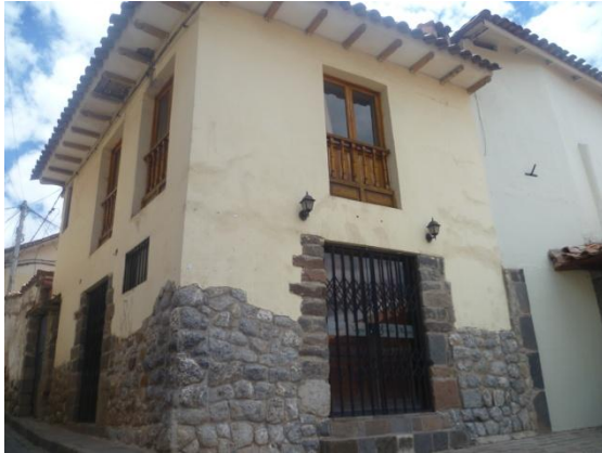
Figura 22. Edificaciones de piedra-adobe.
