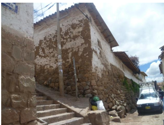
Figura 25. Edificaciones de adobe con base tipo pircas de piedras.
