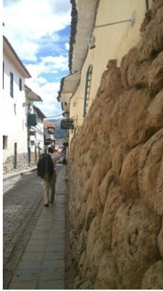
Figura 26. Muros trapezoidales en edificaciones de piedra- adobe.
