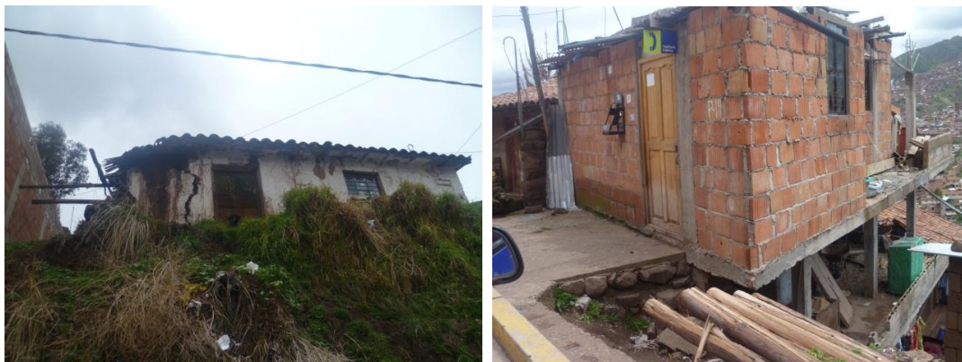
Figura 32. Viviendas de adobe y albañilería del Sector 06.
