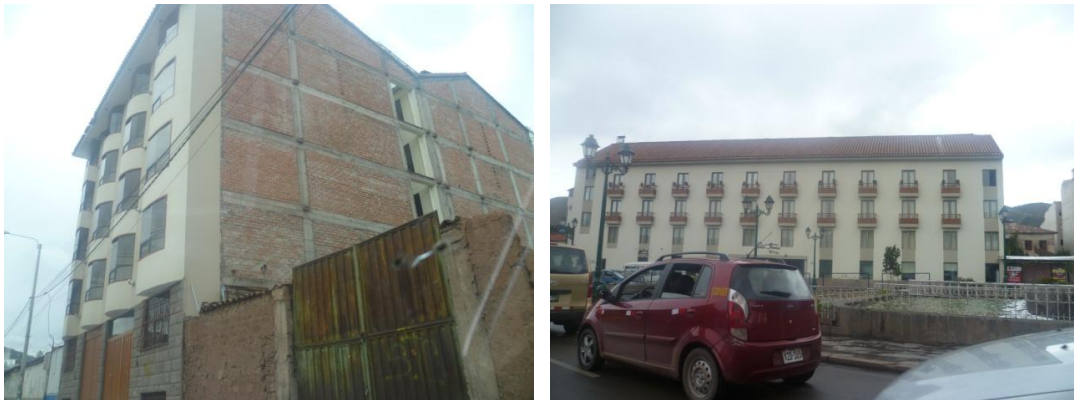
Figura 30. Edificaciones porticadas de varios niveles del sector 05.
