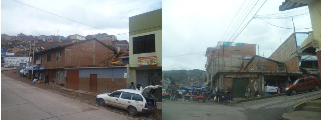
Figura 29. Viviendas de albañilería del sector 05.
