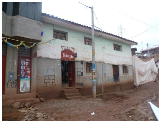
Figura 42. Edificación de adobe al lado de edificación de mampostería. Ambas con uso de vivienda y comercio a la vez.
