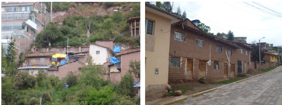
Figura 17. Viviendas de adobe.
