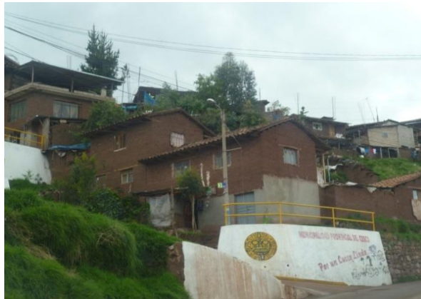
Figura 34. Edificaciones adobe ubicadas en pendiente de cerros. Regular estado de conservación. Uso destinado a vivienda.
