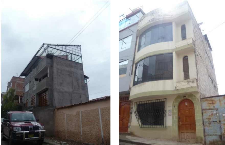
Figura 16. Viviendas de albañilería.
