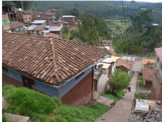
Figura 37. Edificaciones de adobe ubicadas en laderas de cerros. Se aprecia la cubierta de tejas acanaladas de arcilla cocida.
