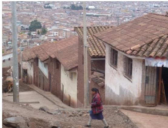
Figura 36. Edificaciones de adobe ubicadas en laderas de cerros. Se aprecia la cubierta de tejas acanaladas de arcilla cocida.
