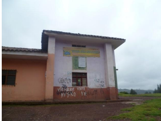
Figura 43. Edificación de adobe de dos niveles con refuerzo de contrafuertes de adobe en las esquinas.
