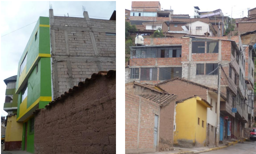
Figura 13. Edificaciones con deficiencias constructivas.
