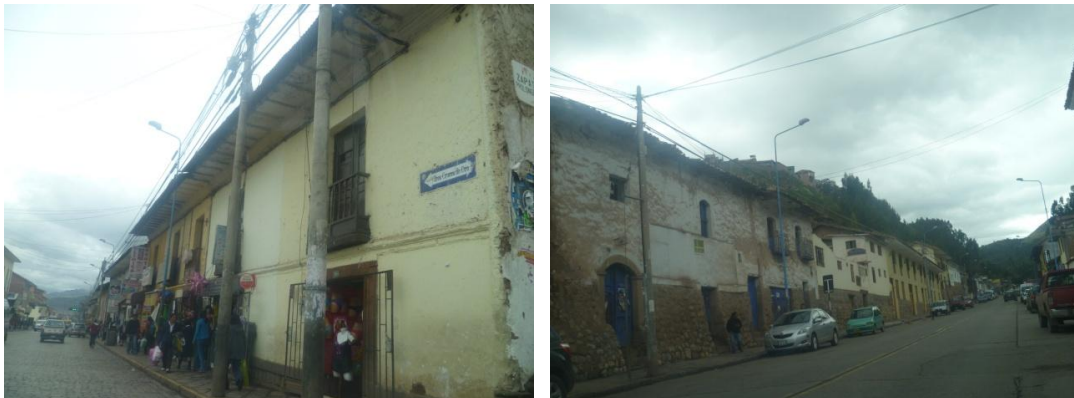
Figura 28. Viviendas de adobe de dos niveles del sector 05.
