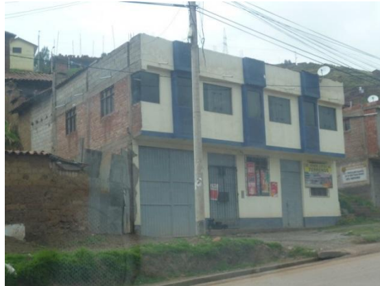
Figura 41. Edificación de mampostería de dos niveles con uso destinado a vivienda y comercio. Buen estado de conservación.
