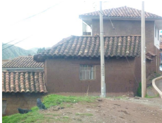
Figura 33. Edificación típica de adobe de dos pisos con techo en pendiente a dos aguas. Uso para vivienda. Regular estado de conservación.
