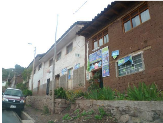
Figura 35. Edificaciones de adobe de dos niveles con uso destinado a vivienda y comercio.
