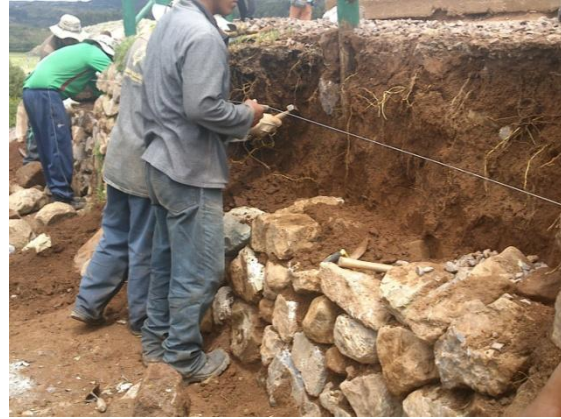
Figura 27. Construcción de pircas de piedras.
