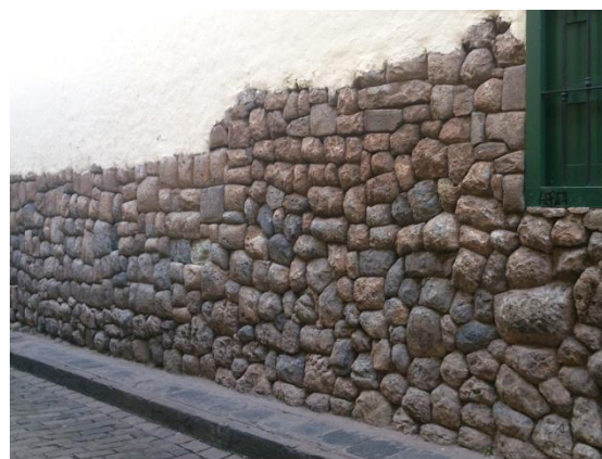
Figura 25. Edificaciones de adobe con base tipo pircas de piedras.
