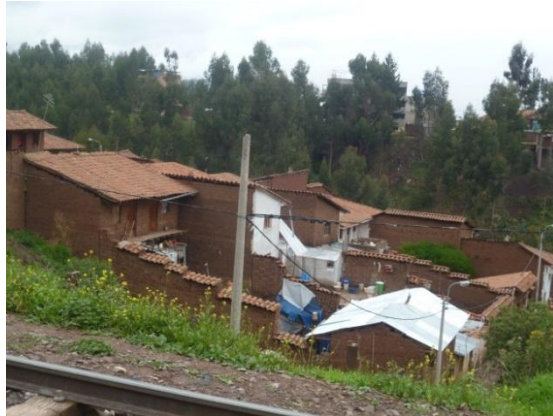
Figura 44. Edificaciones de adobe ubicadas en laderas de cerros. Se aprecia la cubierta de tejas acanaladas de arcilla cocida.
