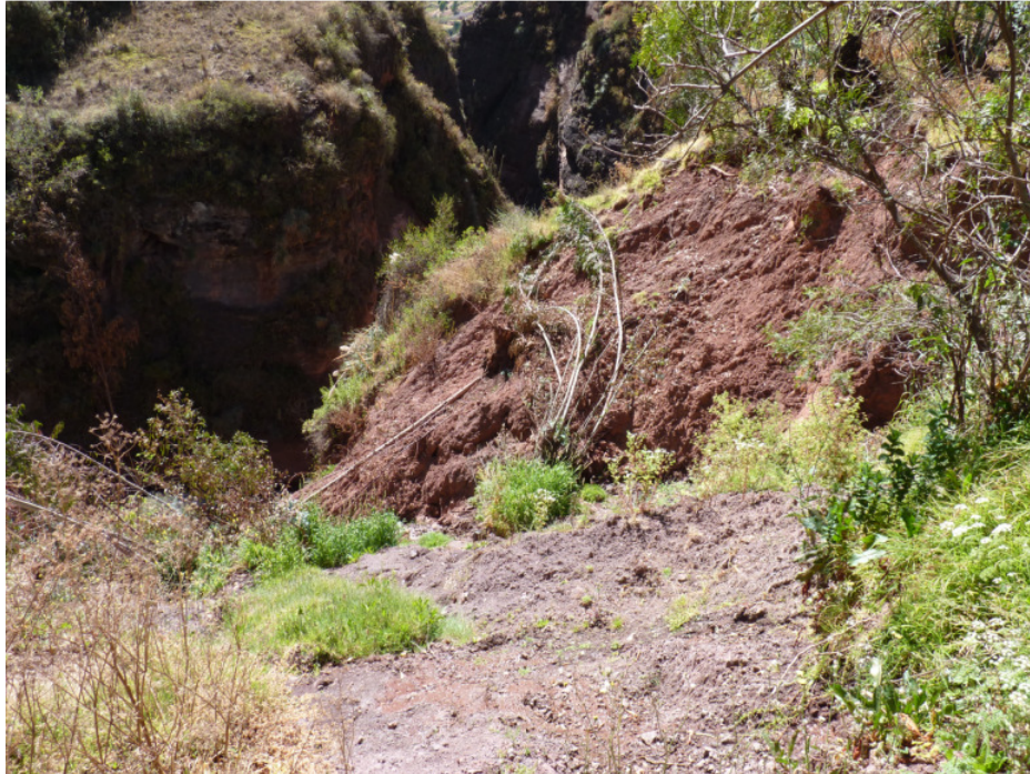
Derrumbes secundarios frente a una cárcava local
