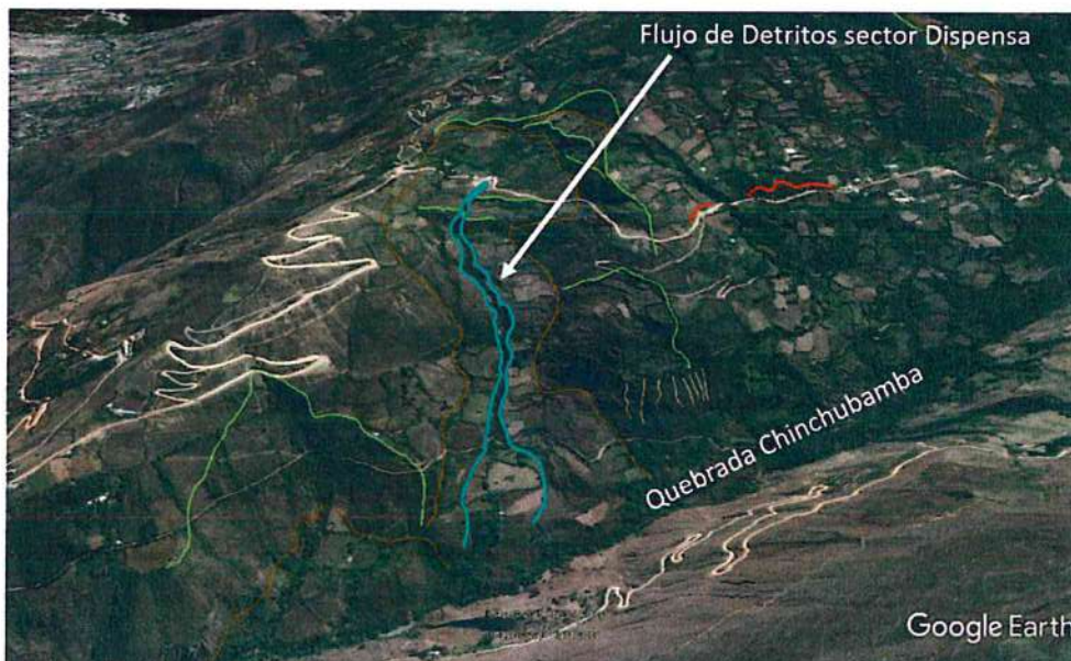
Figura 28: Imagen satelital de Google Earth donde podemos mostrar los flujos de detritos que pasaron por la quebrada del sector Dispensa y que afectaron a una vivienda y chacras de la zona.
