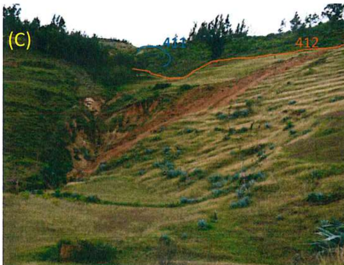
Figura 21: Análisis comparativo de imágenes satelitales de los años 2005 y 2007, y la foto tomada en la presente evaluación: (A): Año 2005 sin presencia de deslizamientos en el punto 411 (punto donde se hizo observaciones) y se ve los materiales antiguos movidos y sus escarpas. (B): Año 2017 al mejorar la carretera arrojan material a la quebrada y generan deslizamientos. (C): Año 2019 se genera un deslizamiento en el punto 412 (punto donde se hizo observaciones) dentro del material antiguo movido, por debajo de la cárcava antigua.
