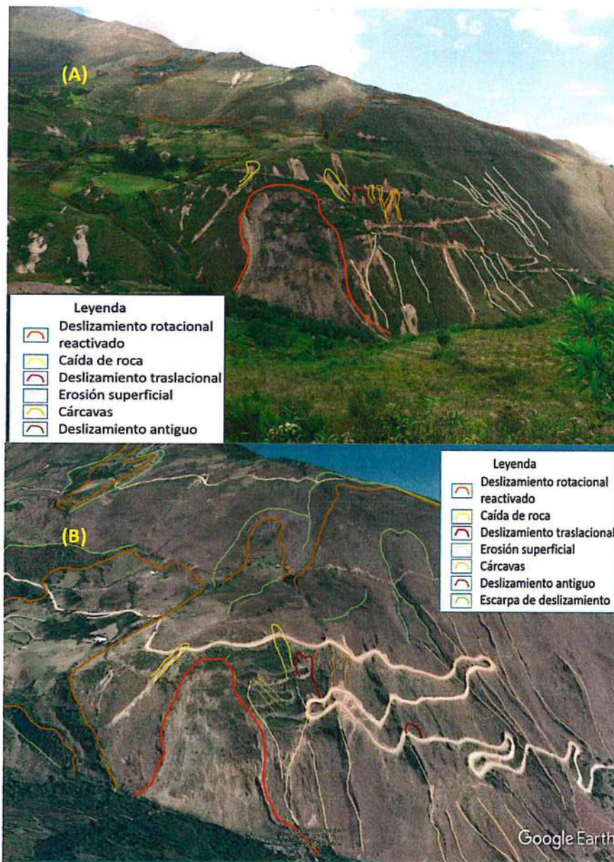
Figura 32: (A): imagen actual del deslizamiento en la carretera a Chinchubamba, donde se aprecian diferentes eventos con líneas según la leyenda. (B): Imagen satelital del año 2017 que muestra con líneas los eventos existentes, pero no existiendo algunos de los eventos nuevos, generado por no realizar las recomendaciones que se dieron en el primer informe.
