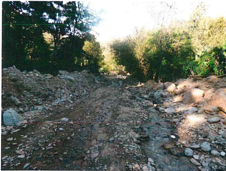
Fotografía 3: Se aprecia los materiales depositados sobre la quebrada, conformados por fragmentos de roca con diferente tamaño, en matriz areno limosa.
