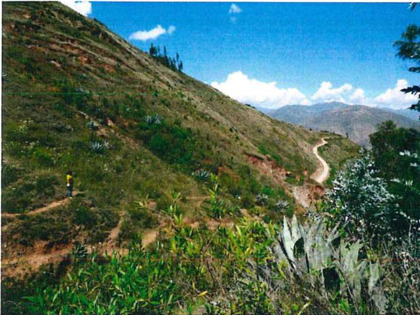
Fotografía 4. Se aprecia el deslizamiento reactivado.
