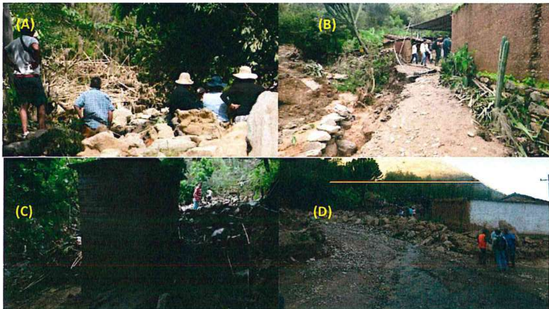
Figura 25: (A), (B), (C): Se muestra el flujo que se dio a comienzos del año presente en la quebrada Toyocote, donde se aprecia el tipo y tamaño de material arrastrado por el huaico y los daños ocasionados, fotos tomadas por personal del Municipio. (D): Durante la inspección se aprecia el trabajo de limpieza realizado por los pobladores de del sector.
