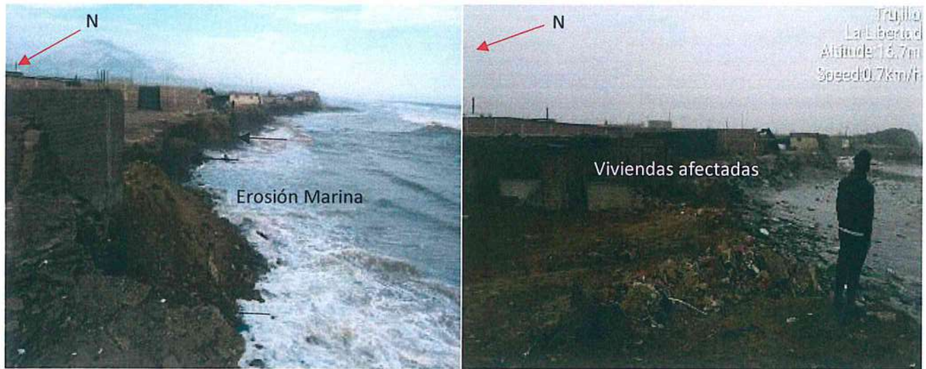
Figura 13 y 14. Vista de viviendas afectadas por acción erosiva del mar, debido al oleaje anómalo marino, que se presenta periódicamente en las costas del norte del Perú, esto ocurrió en abril-junio del 2019. Fuente: Elaboración propia 2019
