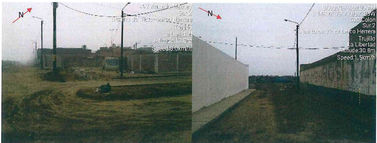
Figura 18. Evidencias de flujos de lodo que afectaron la seguridad física del distrito de Víctor Larco Herrera, registrados en las últimas lluvias de El Niño Costero 2017, que provocaron el rompimiento del dique artesanal, por aumento de caudal de la quebrada San Idelfonso. Vistas del sector de Buenos Aires, donde el flujo de lodo alcanzó una altura de 0.60 mm en la Av. Colón con sus intersecciones de las calles: Zarumilla, Abraham Valdelomar, El Encanto, Piura y Salaverry. Fuente: Elaboración Propia 2019
