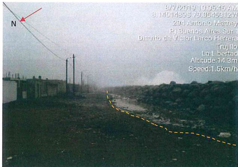
Figura 20. Evidencias de empozamientos de aguas marinas por choque de olas en el enrocado, identificado a inmediaciones de la calle Tacna y Víctor Larco con intersección con la calle Colón. Fuente: Elaboración Propia 2019
