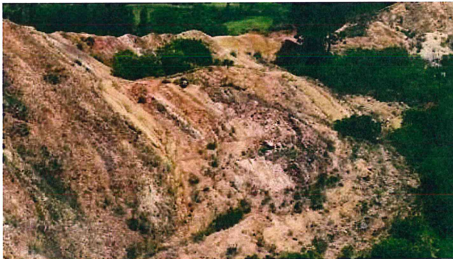
Foto 03: Afloramiento de areniscas y arcillitas con moderada a alta meteorización.
