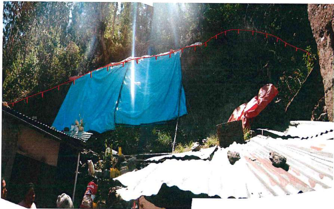
Figura 10. Vista al noreste del barrio San Juan, se observa derrumbe que afecto a vivienda, así mismo colapsaron algunos árboles de eucaliptos; se observa que el derrumbe está cubierto con un plástico con el fin de que no caiga material producto de las lluvias.
