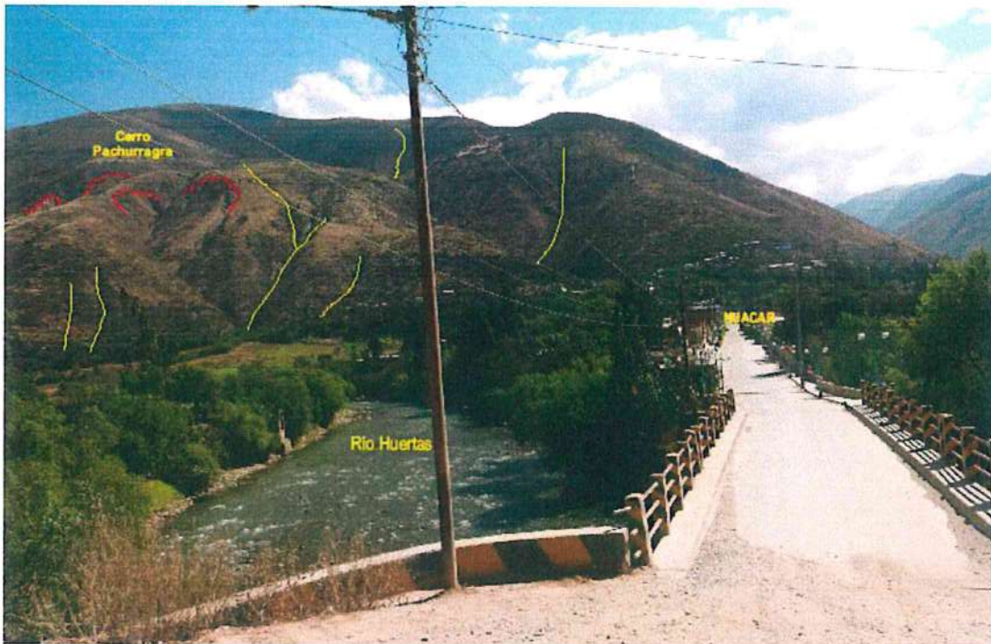
Figura 11. A la margen derecha de la ciudad de Huacar se ubica el cerro Pachurragra, donde se identificaron derrumbes antiguos acompañados con erosión de laderas (cárcavas),
