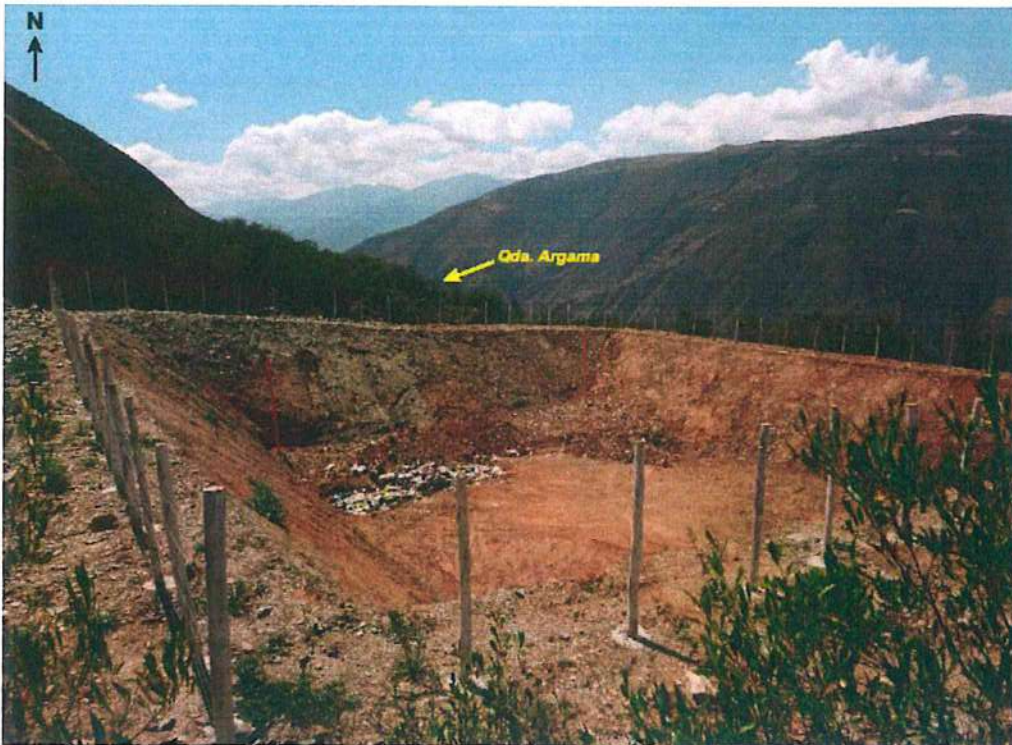
Figura 13. Relleno sanitario construido por la municipalidad de Huacar, en febrero del presente año, ubicado en la cabecera de la quebrada Argama, entre las coordenadas 363356 E, 8873514 N, con una cota 2613 m.s.n.m.
