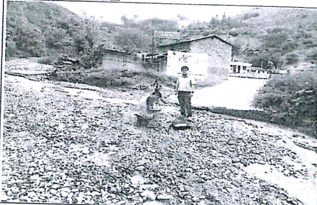
Fotografía N°1: Se aprecia la confluencia de la Zánora Atoy, al ingreso al pueblo del mismo nombre, requiere intervención de limpieza, descolmatación y protección.
