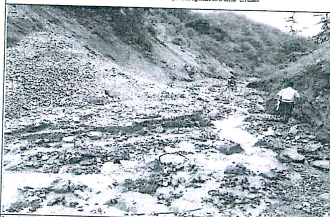
Fotografía N°5: Vista de la parte alta de la Zánora de Atoy colmatada con material sedimentado, por efecto de las múltiples avenidas presentadas en respuesta a las intensas lluvias.
