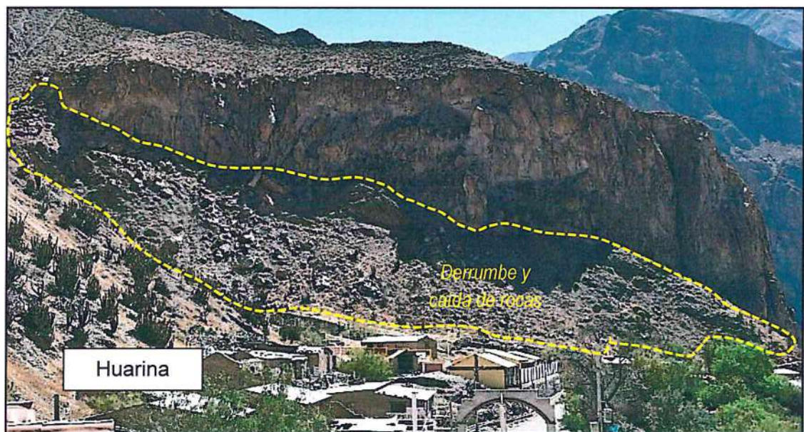
Figura 14. Derrumbes y caída de rocas colindando al pueblo de Huarina.
