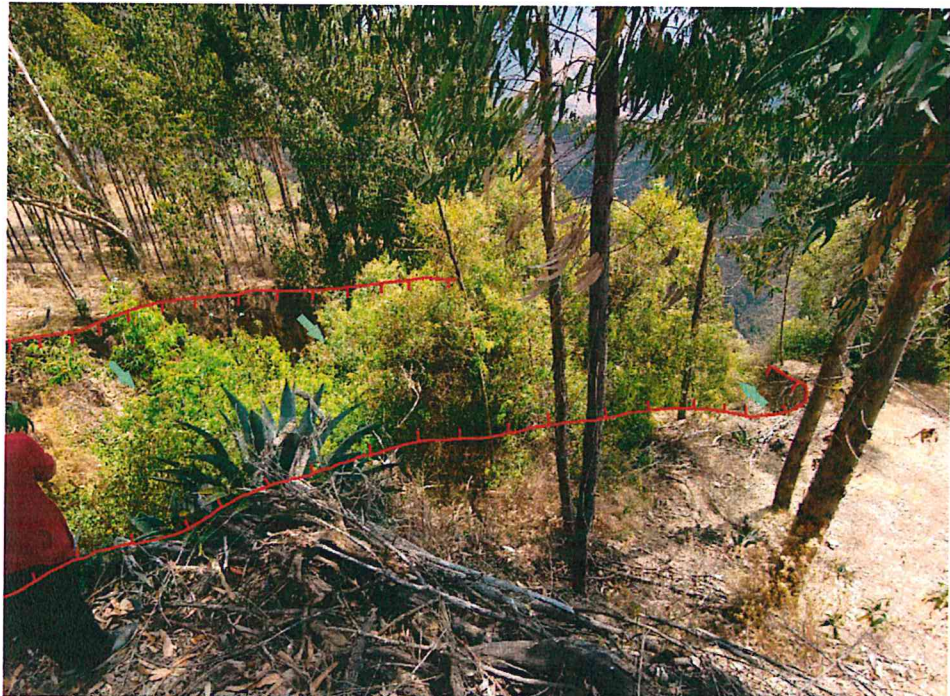
Figura 10. Vista en donde se ha señalado derrumbes, los que se localizan en el cuerpo del deslizamiento antiguo, algunos árboles se encuentran inclinados
