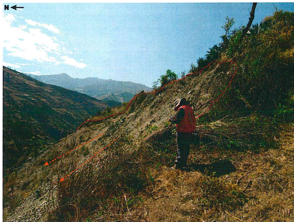
Figura 16. Vista de la escarpa del derrumbe, está delimitado de color rojo, en sus márgenes se observó cultivos de granadilla y alfalfa, se encuentra en las siguientes coordenadas UTM 341730 E, 88466100, cota de 3004 m.s.n.m.
