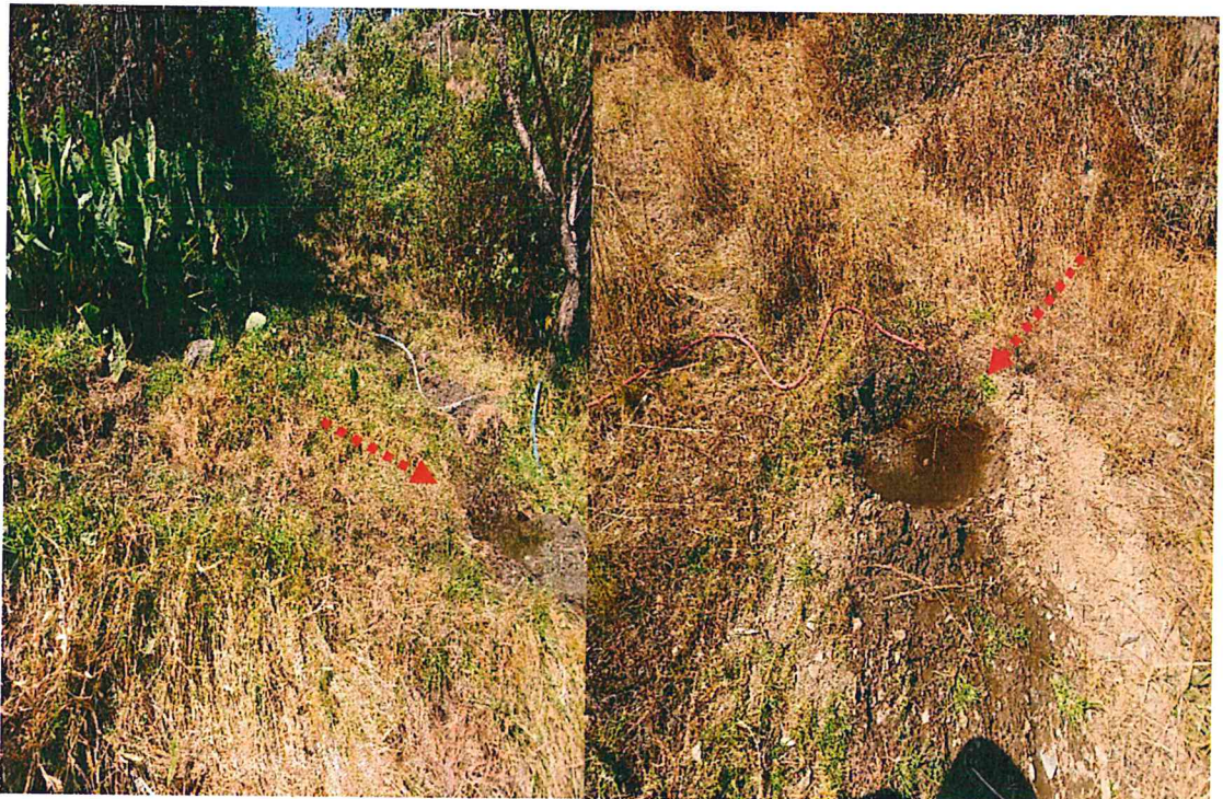
Figura 18. A cinco metros de la escarpa del derrumbe, se está haciendo uso inadecuado de riego (inundación) por parte de los pobladores de la zona, lo que estaría generando saturación del suelo a largo plazo, se encuentran en las coordenadas UTM341734 E, 8846107 N, con cota 3005 m.s.n.m.
