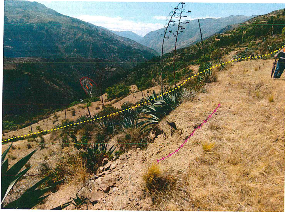
Figura 11. Agrietamiento de 0.05m dentro del deslizamiento antiguo, desde ese punto se observa derrumbe al NW de Chacayan, se encuentra dentro de las siguientes coordenadas UTM 342567 E, 8846616 N, con una cota de 3221 m.s.n.m.
