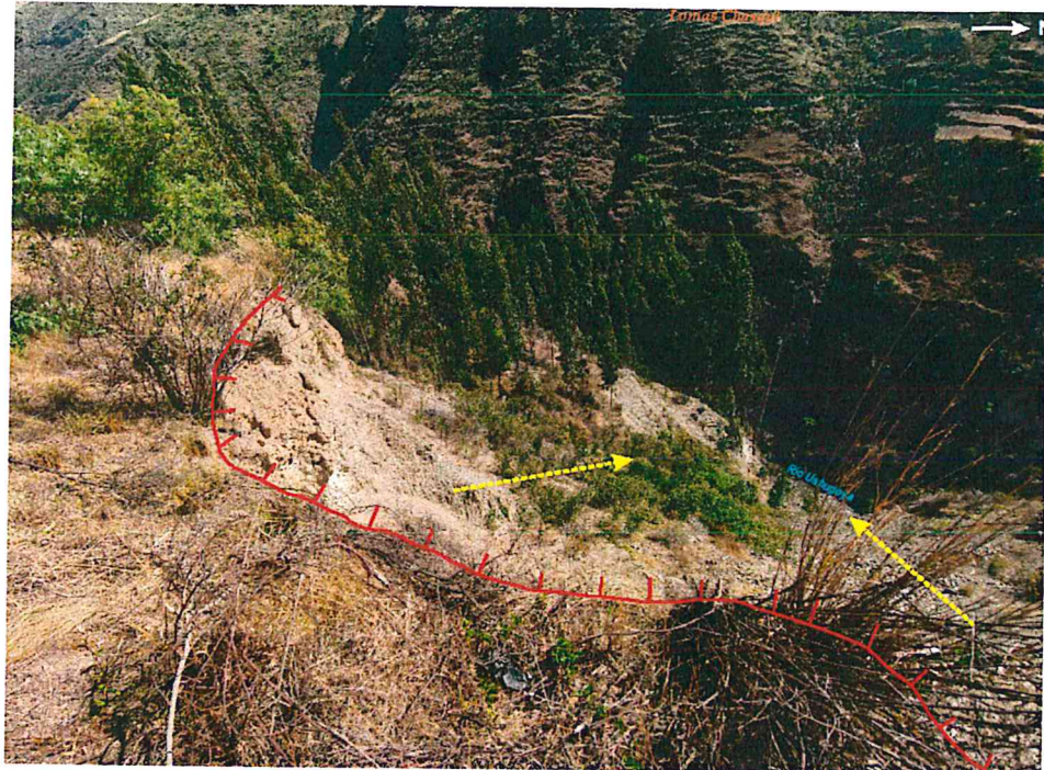
Figura 17. El material desplazado del derrumbe se deposita en la carretera y el río Ushugoya, en temporadas de lluvias, afectando el tránsito vehicular
