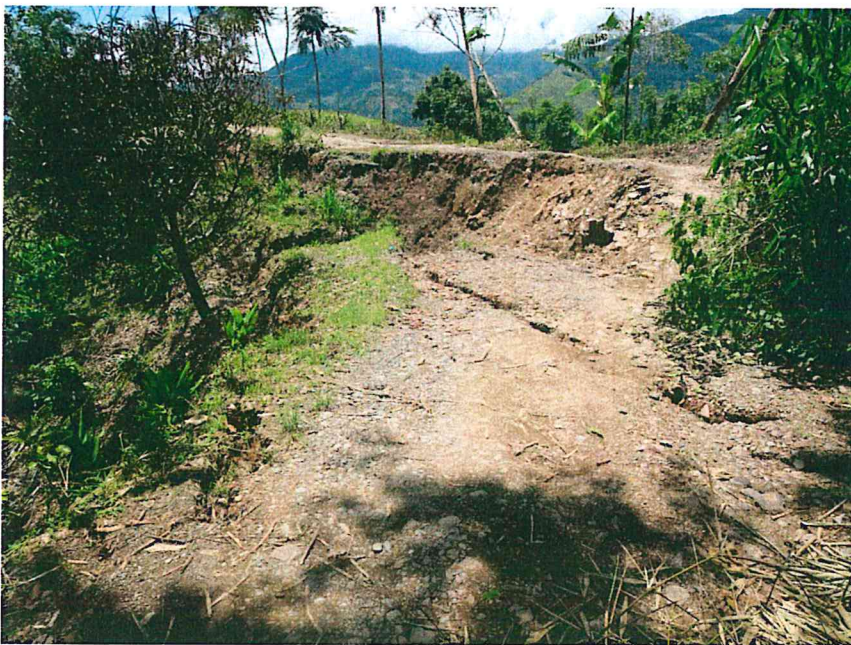
Fotografía 03. Vista del escape principal con salto vertical de 5m, afecta tramo de carretera afirmada.
