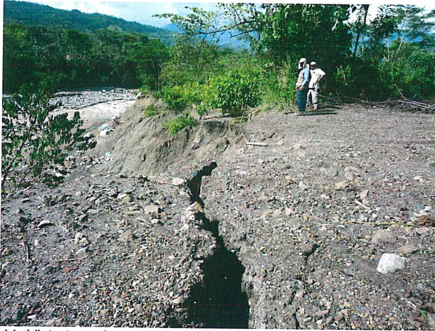
Fotografía 11, Vista tomada con dirección noreste en la coordenada UTM 636502 E – 8596197 S, es afectado por erosión fluvial, también por derrumbes que se originan en el talud superior de la vía afirmada, la superficie presenta grietas con apertura 0.1 m.
