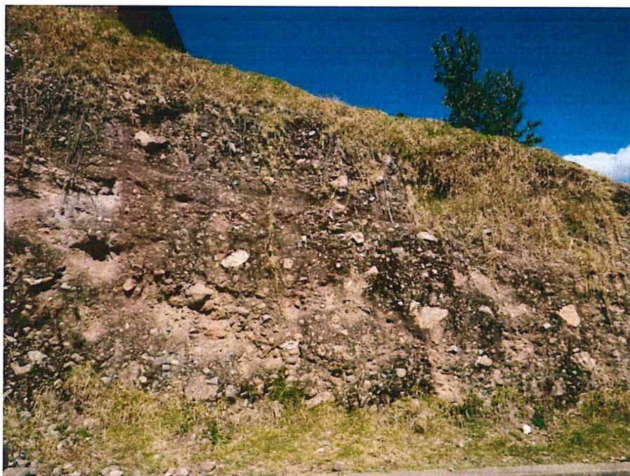
Fotografía 2. Depósitos coluvio-deluviales, sobre los cuales se ubica el centro poblado de Chanchará, formados por deslizamientos antiguos. Vista al suroeste
