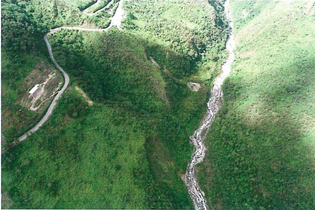
Fotografía 27. Aguas arriba de confluencia con el río Lucumayo, a la margen izquierda se presentan derrumbes, deslizamientos y flujo de detritos.
