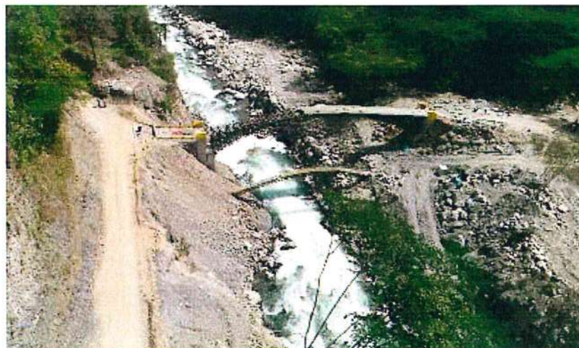
Fotografía 19. Construcción del nuevo puente Iyape en zona susceptible a flujo de detritos y erosión fluvial.
