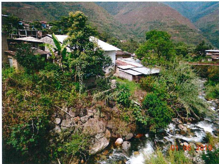
Fotografía 14. A.H. Dos de Mayo, viene siendo afectado por procesos de erosión fluvial y por huaicos excepcionales.
