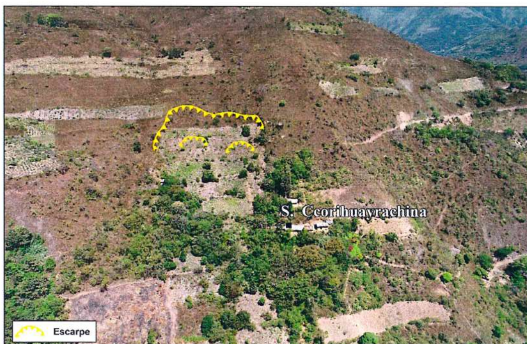
Figura 21. Sector Ccorihuayrachina, se observa el deslizamiento rotacional activo, afectando terrenos de cultivo y viviendas.
