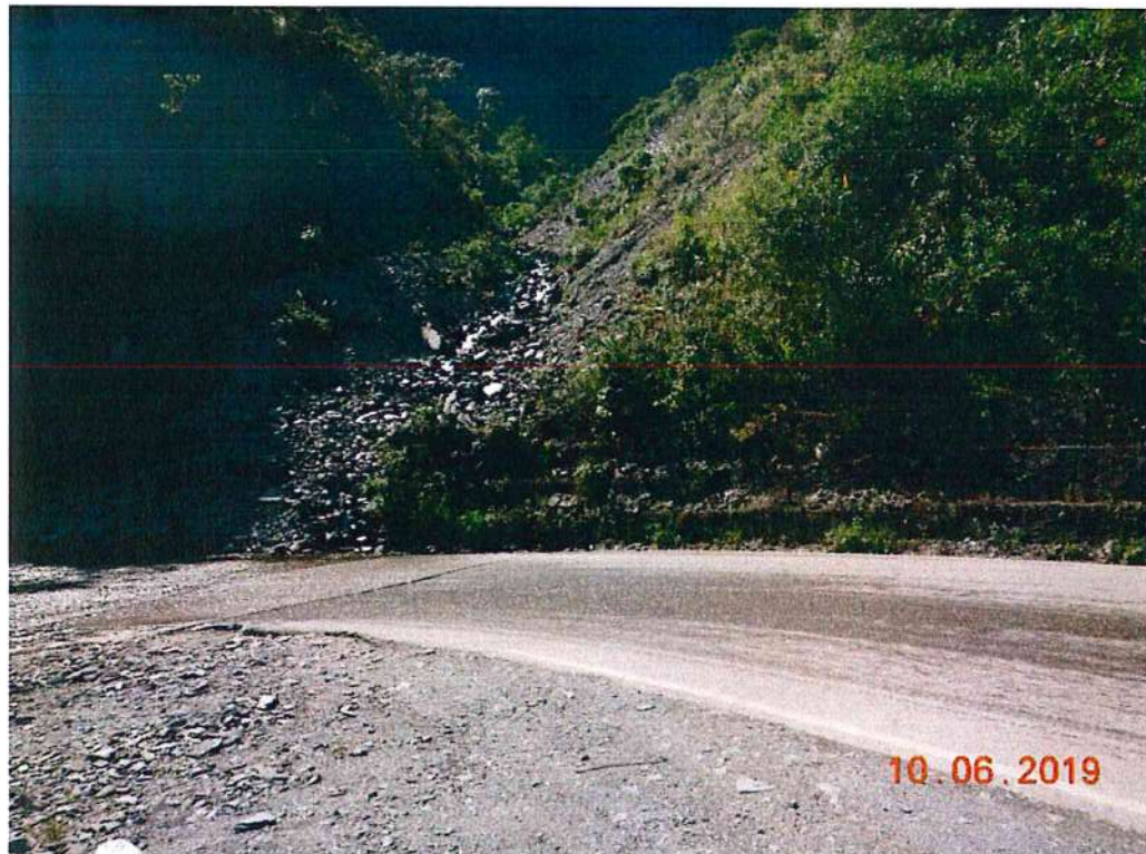
Fotografía 26. Flujo de detritos en la quebrada Jorge Mayo, en el primer tramo de corte de carretera.
