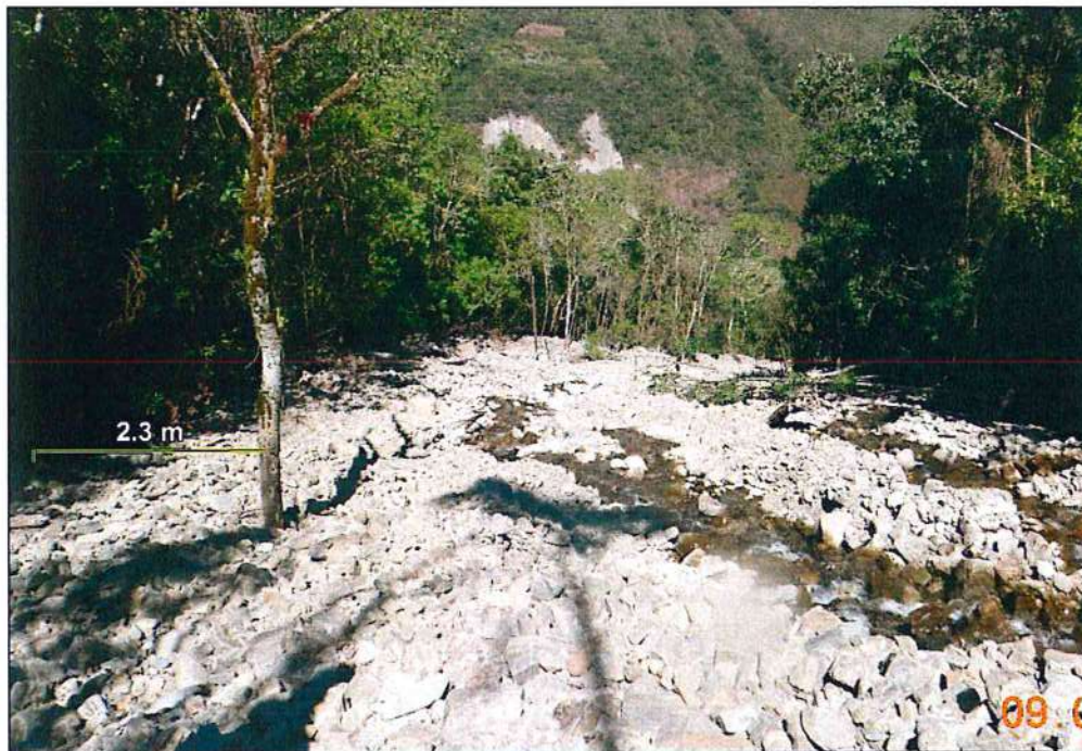
Figura 34. Zona media, ensanchamiento de la quebrada Chaquimayo a partir del árbol señalado.
