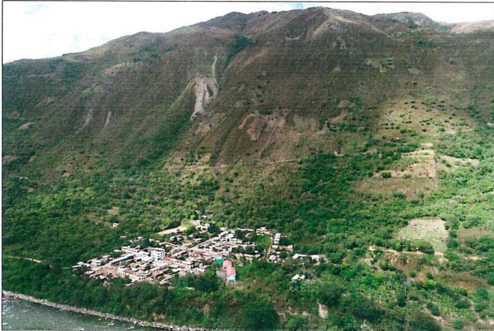
Fotografía 5. Se observa laderas con procesos de erosión, además de deslizamientos antiguos.
