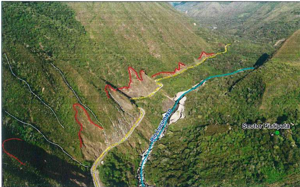
Figura 37. Vista de derrumbes, a lo largo de la carretera (tramo Misquiuno-Incatambo), cuando se reactivan obstruyen la vía de acceso a la ciudad de Quillabamba.
