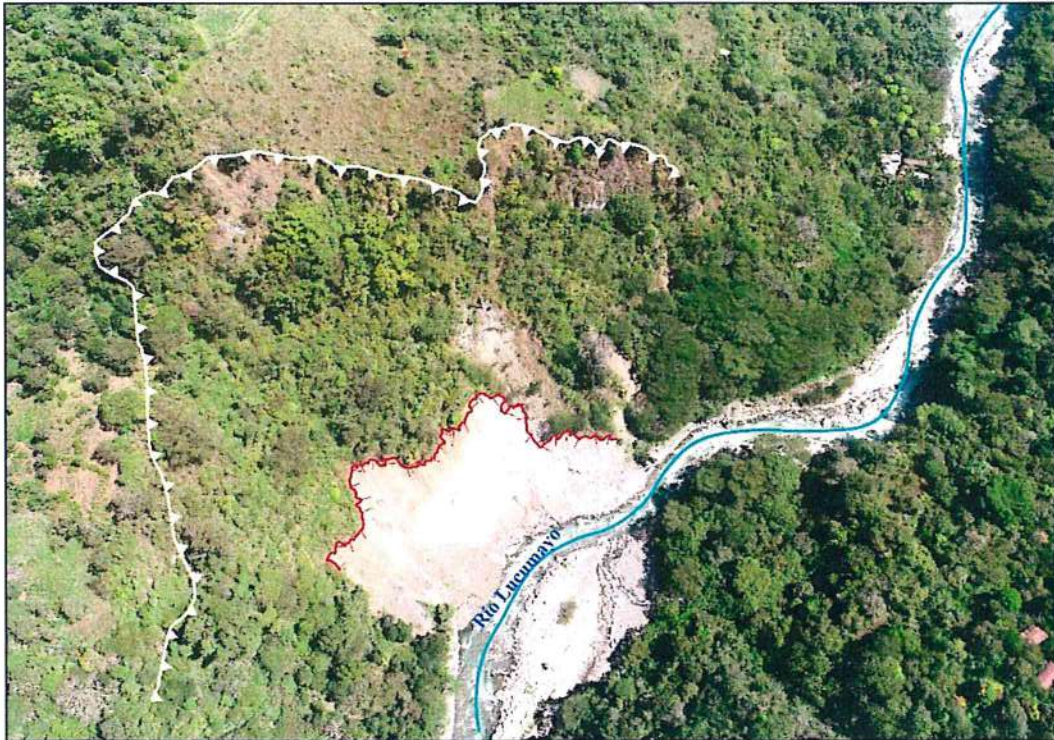
Figura 23. Sector Pedregal, zona afectada por erosión fluvial del río Lucumayo y por flujos provenientes del río Rodeo.
