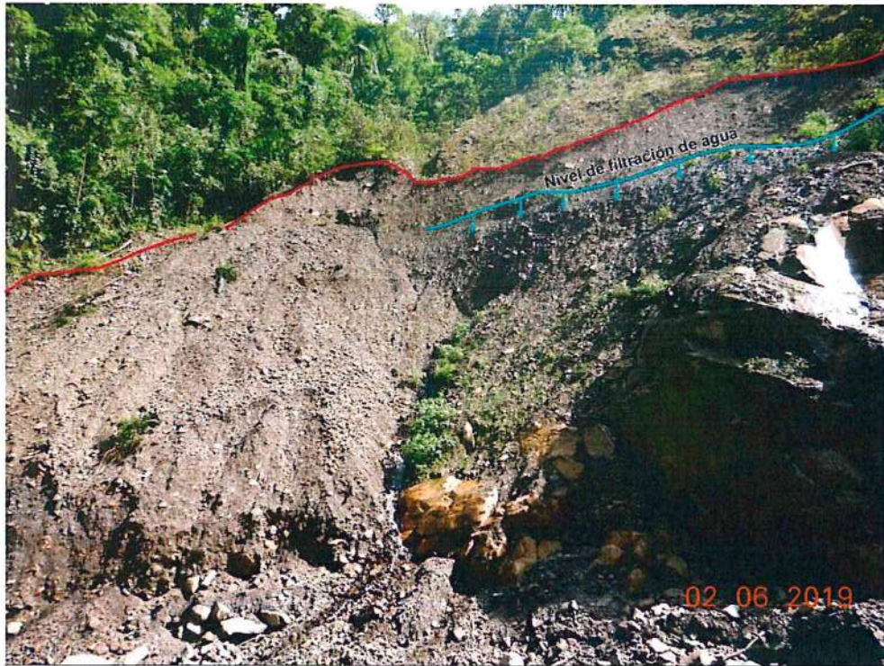
Figura 27. Filtración de agua en la ladera derecha de la quebrada Sicre.
