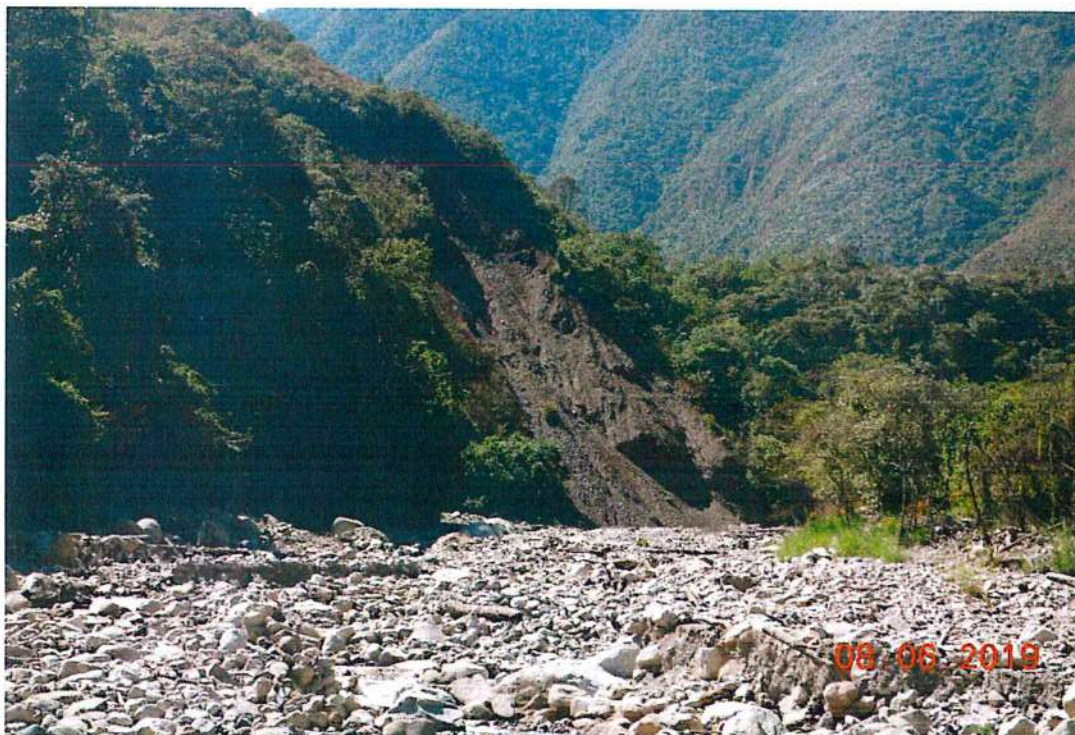
Fotografía 23. Ocurrencia de derrumbes posterior al flujo de detritos.
