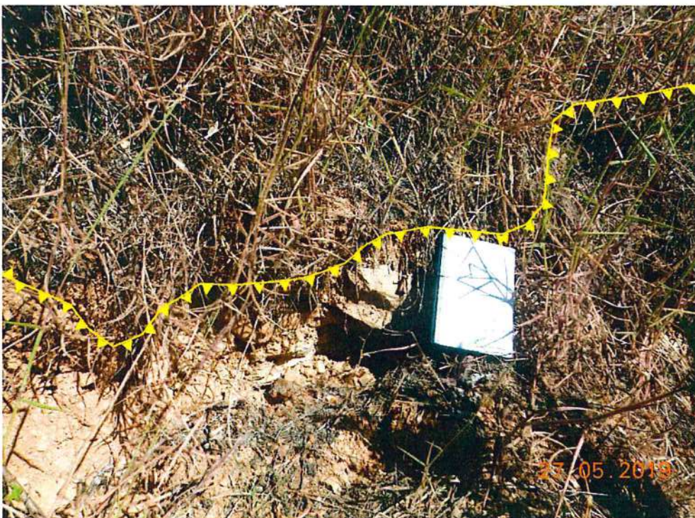
Figura 17. Vista del deslizamiento en proceso de formación
