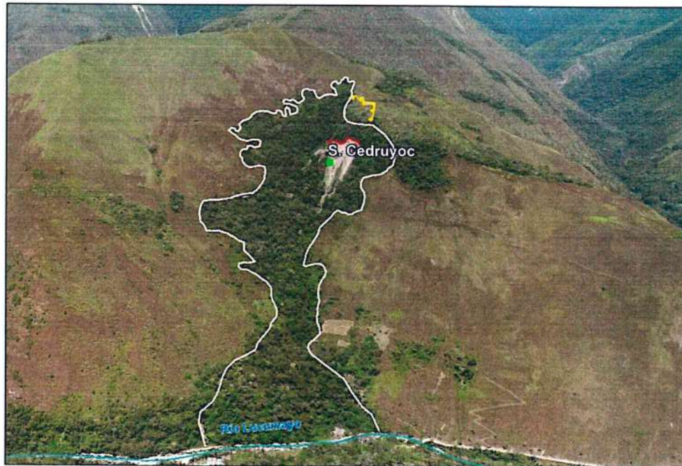
Figura 30. Sector Cedruyoc, se observa erosión de ladera en cárcavas
