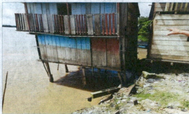
Viviendas adaptadas con palafitos para la inundación, la cual se encuentra en riesgos
