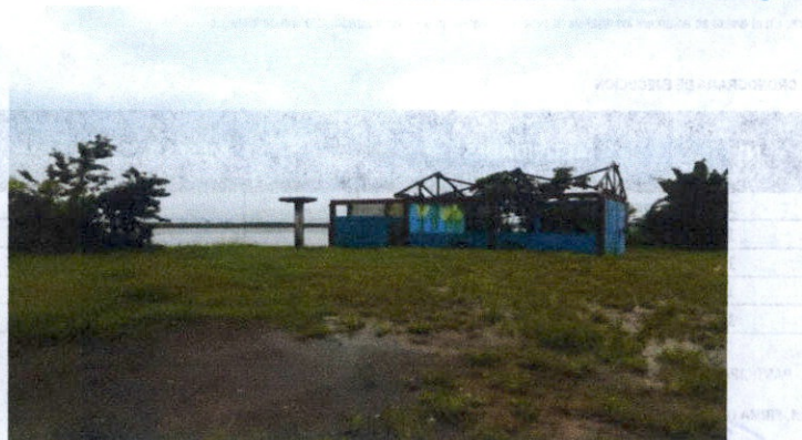
Vista del centro educativo en riesgo, el cual ya fue desarmado y abandonado
