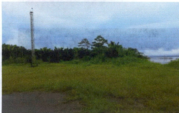
Vista de la zona erosionada cercana a antena de de la empresa Telefonica
