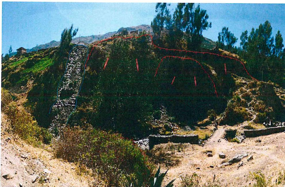
Figura 14. Se observa derrumbe en la margen derecha del río Cuchichaca (delimitado con líneas de color rojo), así mismo se está utilizando como botadero parte del poblado de Cajatambo, lo que podría generar colmatación del cauce del río Cuchichaca.
