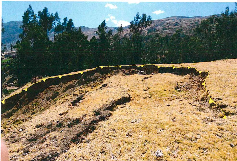
Figura 12. Vista desde otro angulo, se observa que parte del cuerpo del deslizamiento presenta grietas con abertura de 0.10 – 0.20 m, con una profundidad de .015 – 0.25 m, se observó que reforestaron con árboles de pino cada 2m.
