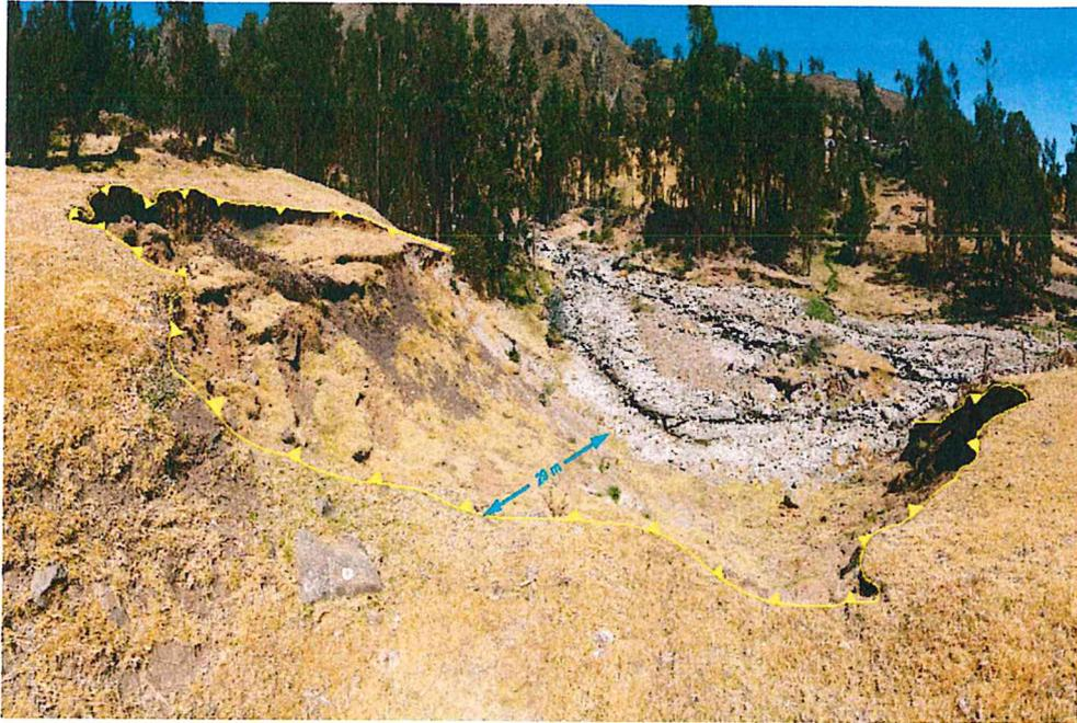
Figura 11. Vista al SW, se observa escarpa elongada, donde se marcó con línea de color amarillo la escarpa principal del deslizamiento, presencia de agua en el suelo. Se encuentra en las siguientes coordenadas UTM 8841117 N, 281930 E, con una cota de 3366 m.s.n.m
