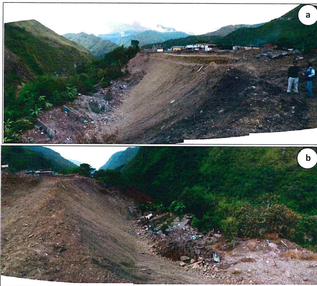
Figura 6: Deslizamiento rotacional del año 2013. a) Vista hacia el sureste donde es posible observar la superficie de ruptura cóncava de deslizamiento y el cuerpo del deslizamiento basculado. b) Vista tomada hacia el noroeste. Fuente: Vílchez M. 2013.
