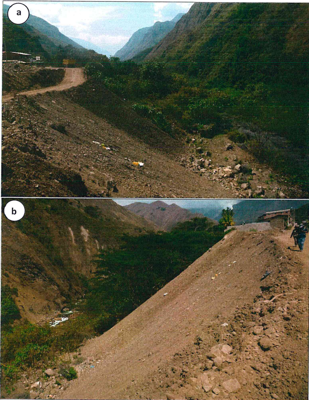
Figura 7: Estado actual del deslizamiento rotacional de Kelcaybamba a) Vista tomada hacia el NE b) Vista tomada hacia el SW
