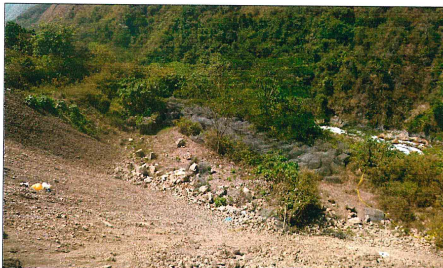
Fotografía 8: Vista de mallas para la construcción de gaviones
