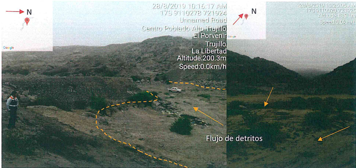
Figura 32. Vista del dique artesanal colapsado por los flujos de detritos transportados por las aguas de la quebrada San Idelfonso reactivada por las lluvias extremas del evento Niño Costero 2017. Aguas arriba actualmente hay material susceptible a ser acarreados como flujos de detritos por una nueva reactivación de la quebrada en mención. Fuente: Elaboración propia 2019
