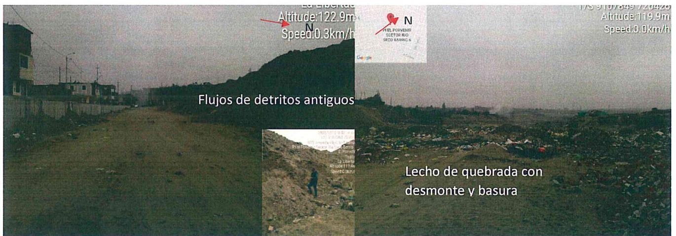
Figura 33. En la parte baja de la quebrada San Idelfonso (Ingreso al distrito de El Porvenir) se identificó materiales consolidados, procedentes de flujos de detritos antiguos depositados por la quebrada San Idelfonso, en la figura del lado derecho se aprecia escombros y basura en el cauce de la quebrada, esta al ser reactivada los transportaría cotas abajo junto con el flujo de detritos afectando a la población de El distrito de El Porvenir. Fuente: Elaboración propia 2019
