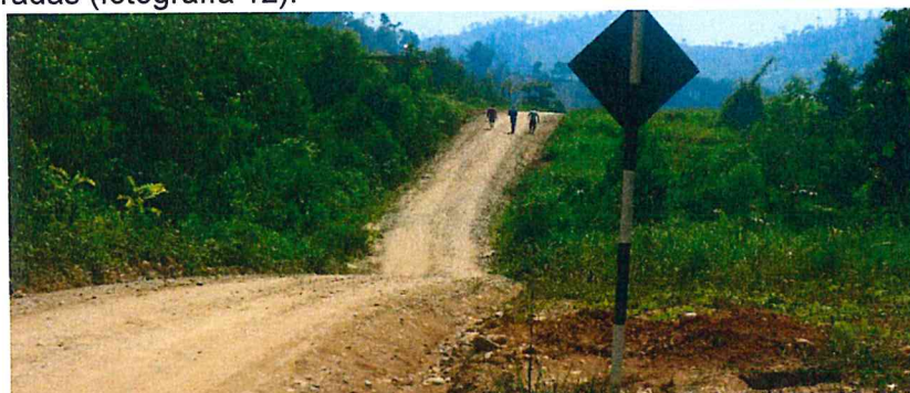
Fotografía 12. Se aprecia una quebrada, este sector no debe se habilitado para la construcción de viviendas u otros de infraestructura. Se debe construir un badén.
