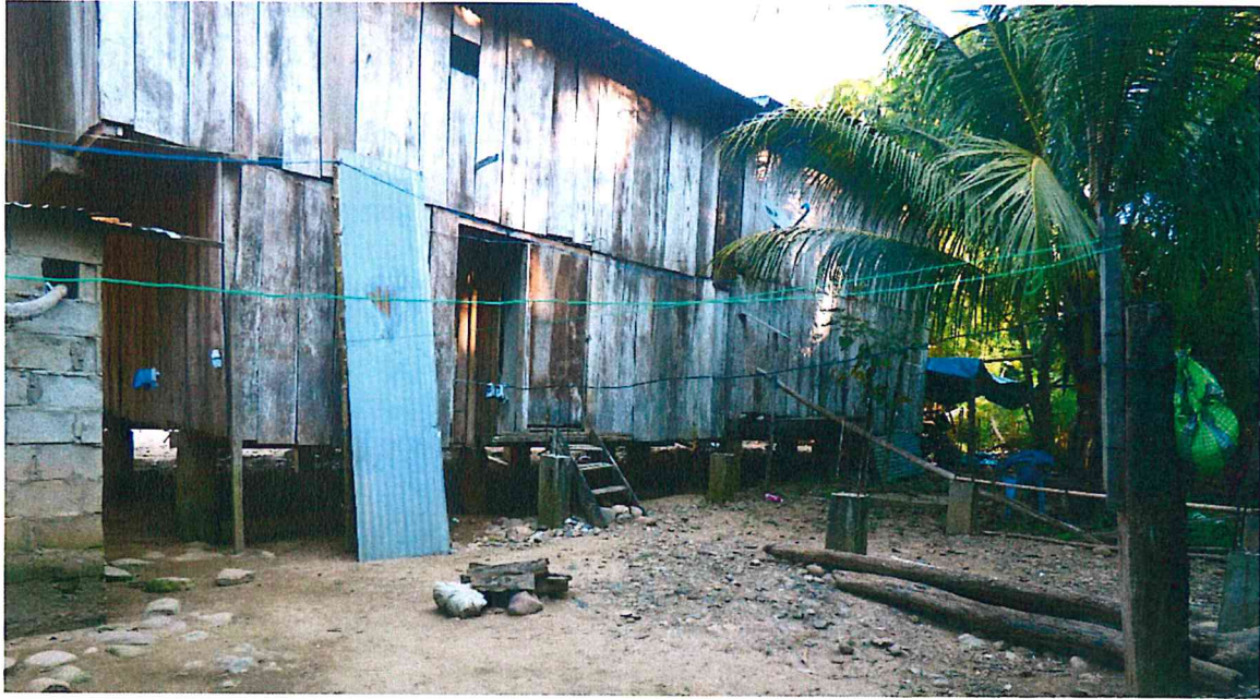
Fotografía 8. Se aprecian viviendas con pilotes de madera, para evitar ser inundadas.
