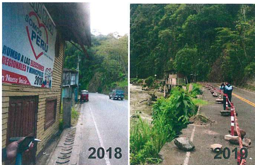
Figura 14. Fotografías tomadas en el mismo sector en años diferentes mostrando el estado anterior y el actual. 2018: Se observan las viviendas emplazadas al borde del río Paucartambo. 2019: Se observa el sector afectado por erosión fluvial que destruyó las viviendas.
