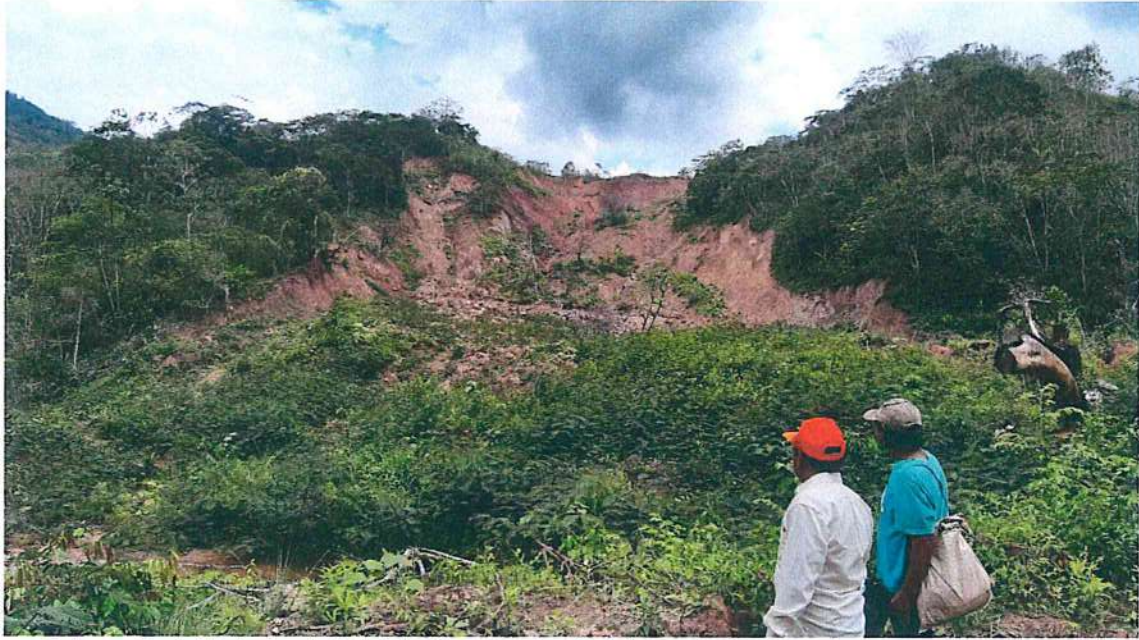
Fotografía 4. Vista frontal del deslizamiento. Se observan la zona de arraque, parte de la masa deslizada y los escarpes laterales.
