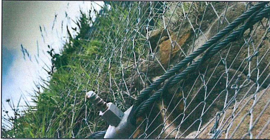
Figura 11. Ejemplo de control de caída de rocas utilizando mallas ancladas.
