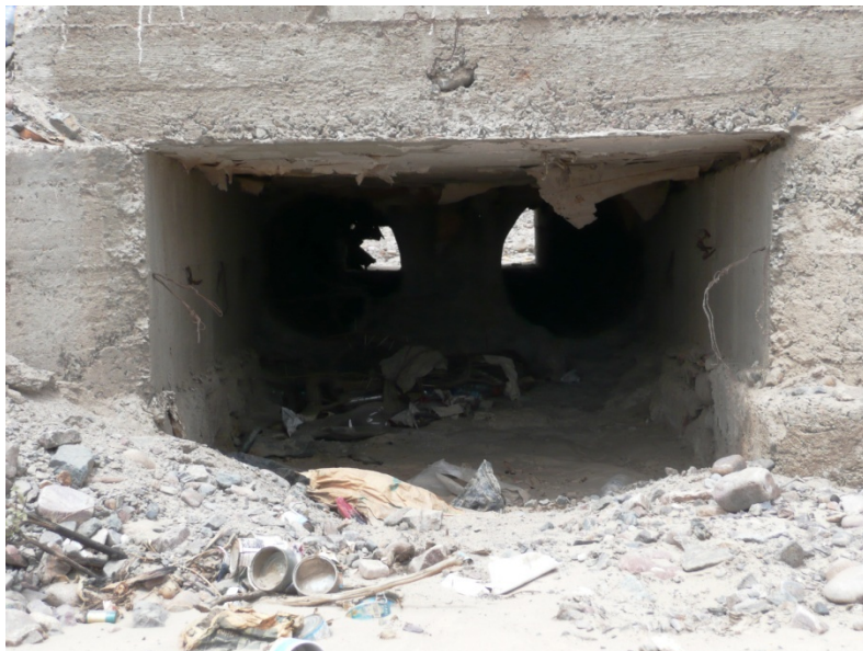
Fig. 15: Vista de la única alcantarilla de la zona, véase que no tiene un diseño adecuado para canalizar y conducir los flujos de agua (o detritos) propios de la zona, poniendo en riesgo la estabilidad de la carretera Panamericana Sur.
