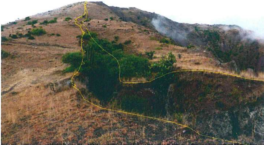
Figura 10: Vista con dirección hacia el sureste donde se observa la escarpa alargada del deslizamiento D1, el cuerpo se ha separado por medio de la escarpa, pero no se ha movilizado.
