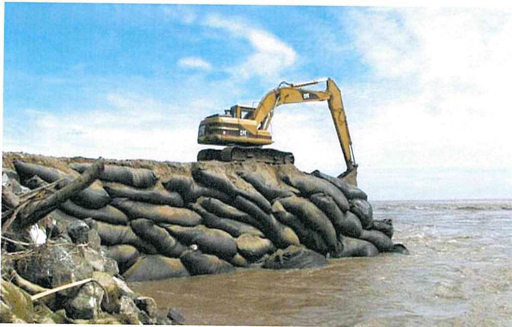
Imagen N° 3 Protección con geobolsas
