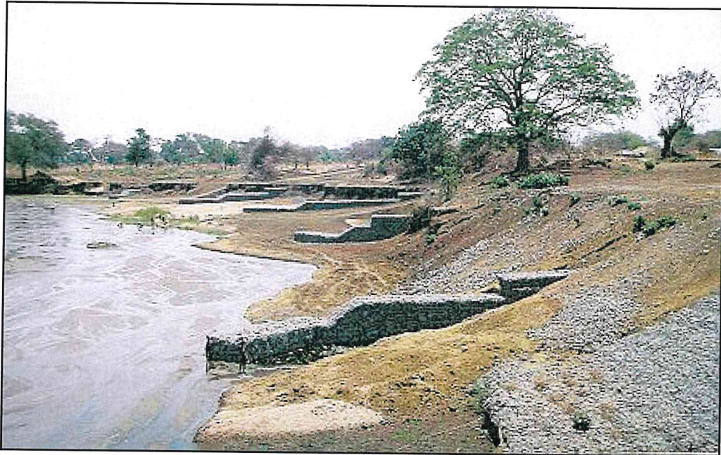
Imagen N°4 Protección con espigones de gaviones
