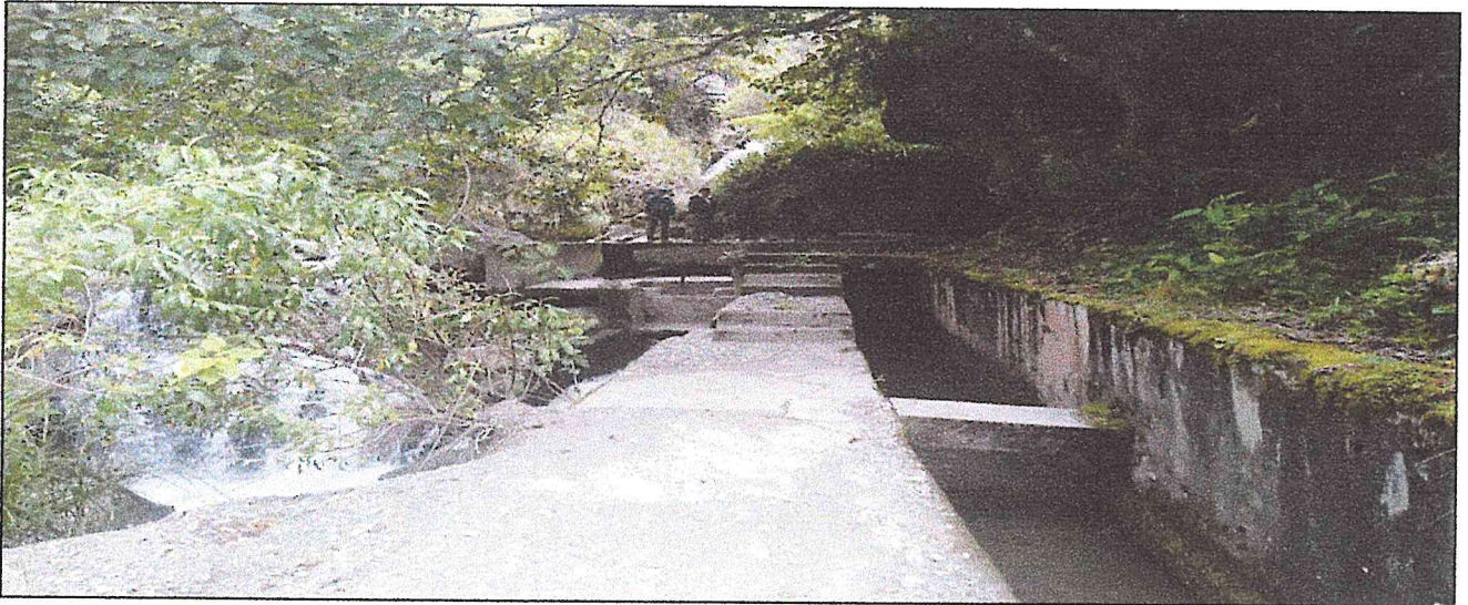
Fotografía N°03: Canal Chantaco la cual no precensia daños en su infraestructura
