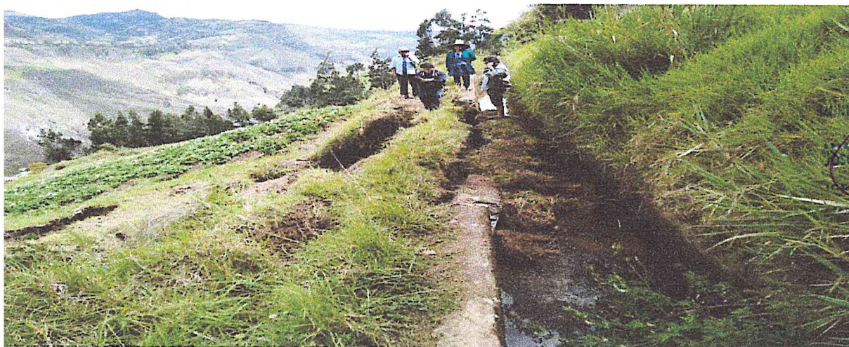
Sección 02: Tramo totalmente deteriorado del Canal Succhil Quispampa
