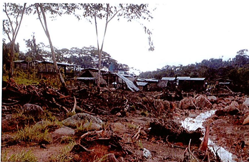
Foto 38. Viviendas afectadas por el flujo de detritos.
