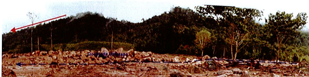
Foto 16. Vista aguas arriba en la quebrada Umazapa, muestra laderas de moderada pendiente, el cauce sobre el cual discurrió el flujo de detritos.
