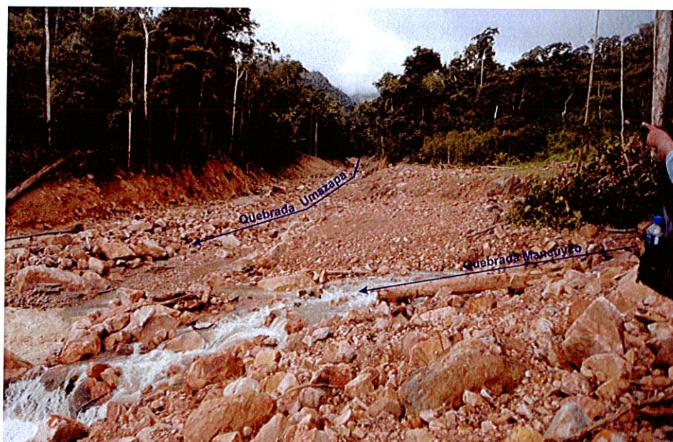
Foto 28. Confluencia de la quebrada Mancuyo en la quebrada Umazapa. Se muestra parte del material acarreado por el flujo de detritos.
