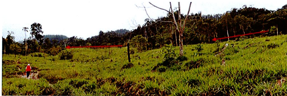
Foto 13. Depósito de remoción que forma una topografía ondulada, originados por un deslizamiento antiguo, margen izquierda de la quebrada Umazapa.
