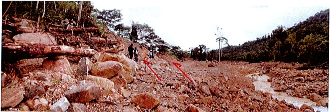
Foto 31. Erosión pronunciada sobre la terraza ubicada en la margen izquierda, por el desplazamiento violento del flujo.
