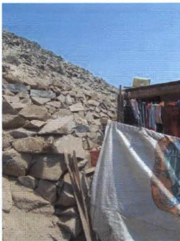
Fotos N° 12 y 13. Se observa pircas altas, sin ningún tipo de amalgamación hasta de 2 m altura, las cuales podrían colapsar por un movimiento sísmico.
