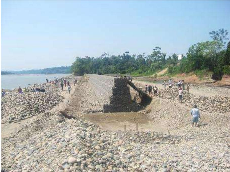
Foto 17b: Gaviones escalonados, construcción
