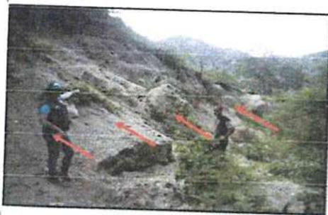
FOTO 1. QUEBRADA HORNOPAMPA - EN LA IMAGEN SE OBSERVA COLMATACION Y DEBILITAMIENTO DE TALUD DE LA MARGEN IZQUIERDA.
