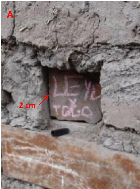
Foto 16: A) Desplazamiento de los listones de madera, el listón de la foto se encontraba 8 cm. fuera de la pared, en el 2008 se encuentra 2 cm dentro de la pared. (Valderrama, 2008). B). Actualmente el listón de madera se encuentra 10 cm dentro de la pared, es decir se ha desplazado 8 cm más desde el año 2008.
