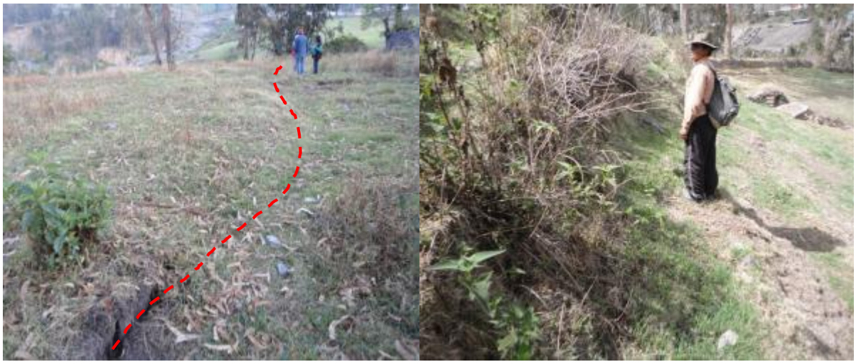
Foto 28: En la vista del lado izquierdo se observa asentamiento de casi un metro en la margen izquierda de la quebrada Shapil; en la vista de lado derecho un pequeño salto, y grietas transversales al flujo de tierra.
