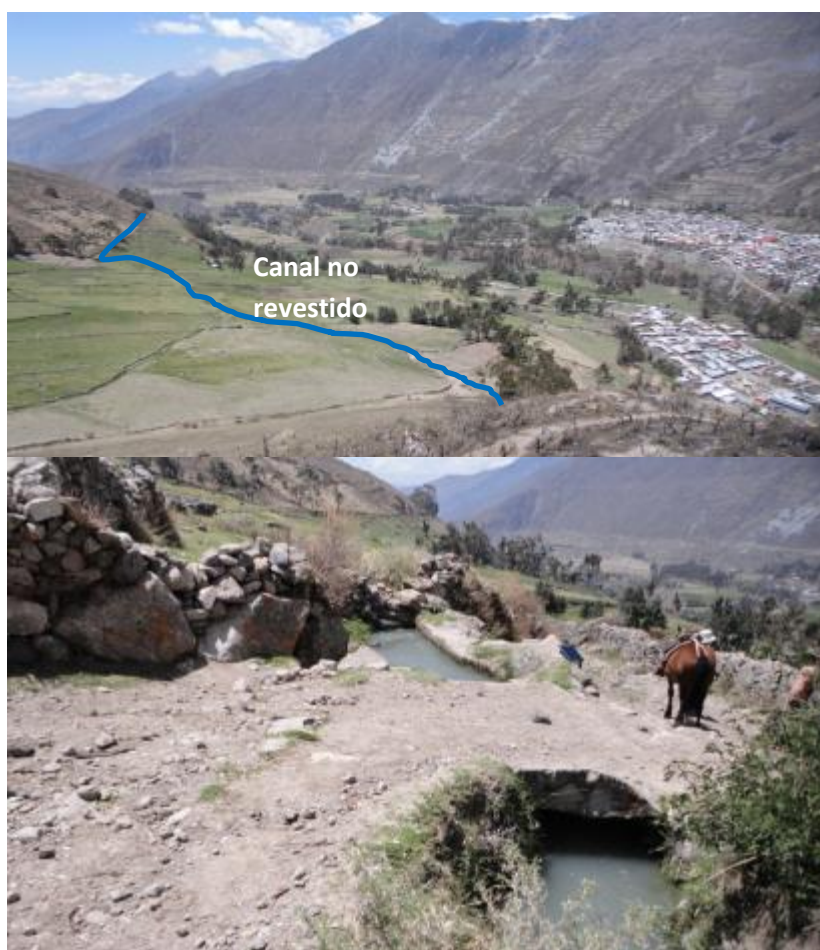
Foto 33: El canal no revestido y el mal uso de las aguas de regadío en los terrenos altos, ubicados encima del anexo de Astobamba, podría también influenciar el comportamiento del flujo de tierra, de ser así se generaría un gran plano de debilidad que comprometería todo el anexo de Astobamba.
