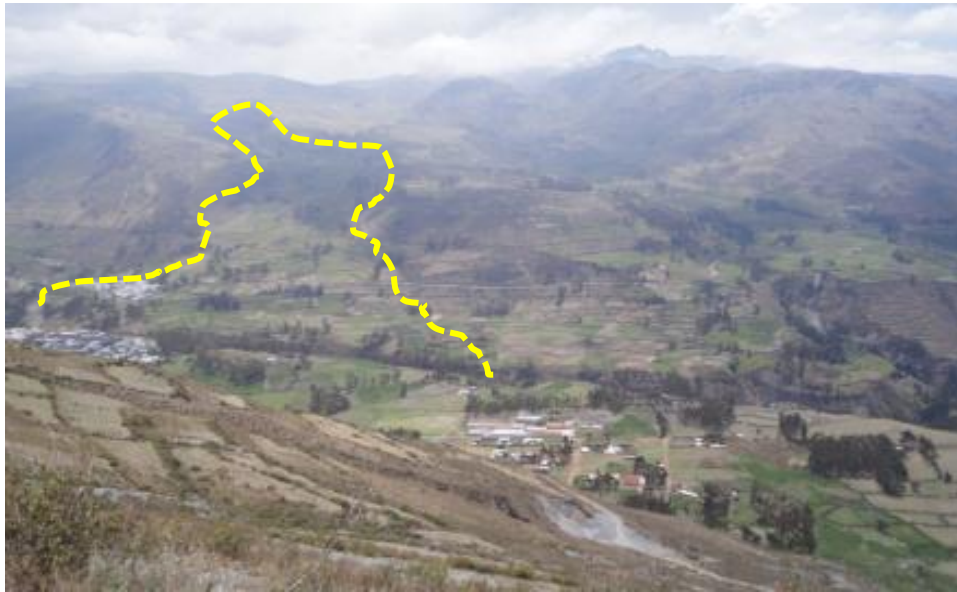
Foto 07: Deslizamiento rotacional en la margen izquierda de la quebrada Shapil.
