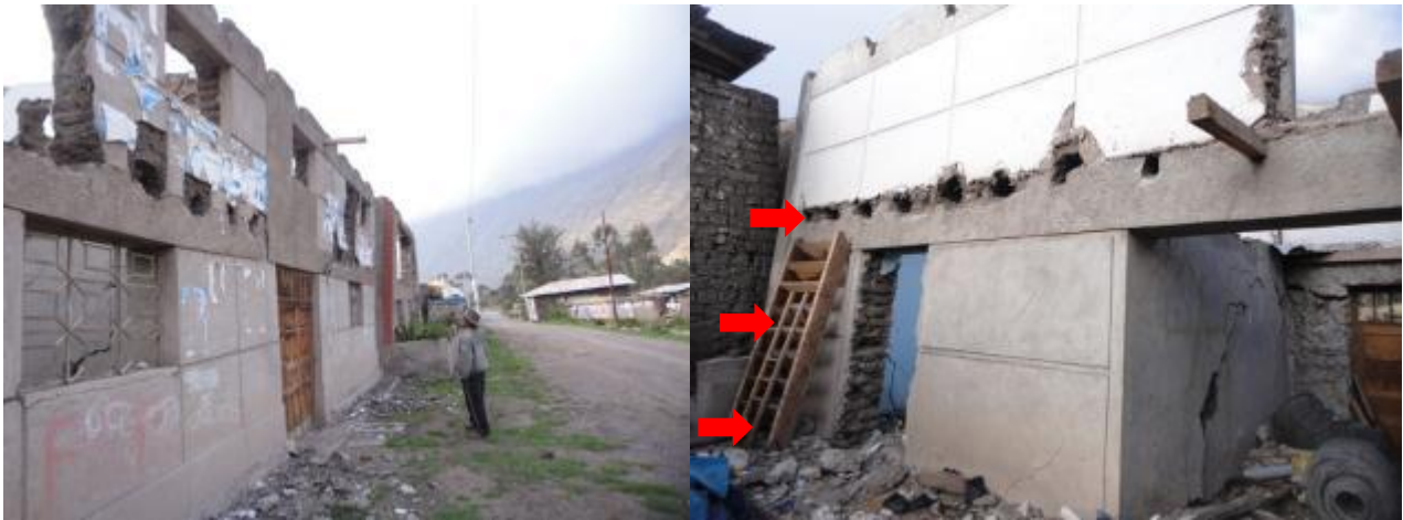
Foto 26: En esta vista se puede apreciar el sentido de dirección del empuje del suelo, producto del flujo de tierra que afecta el sector.
