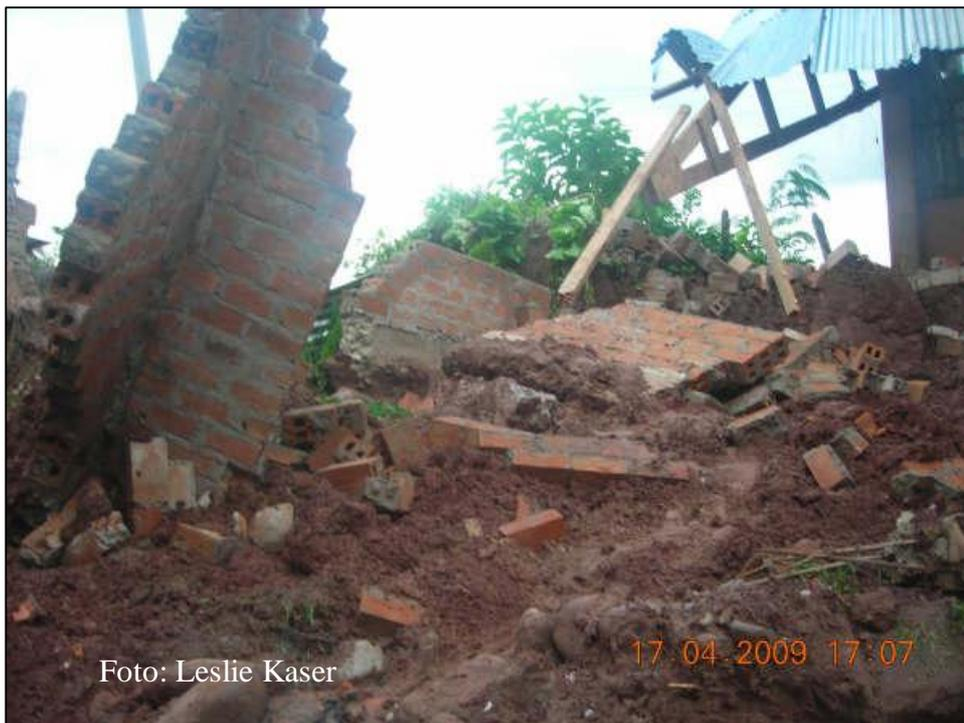
Foto 4 y 5.- Infraestructura que ha colapsado por el deslizamiento-flujo.
