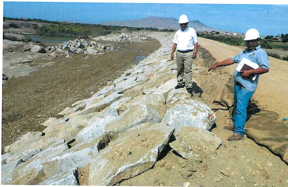
Imagen 01: Protección - dique enrocado acomodado
